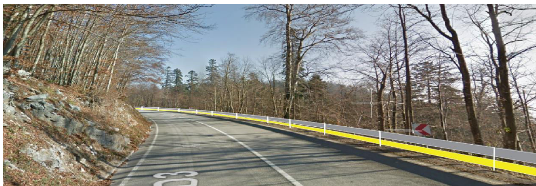
Slika 19: Prikaz posebne zaštitne ograde
