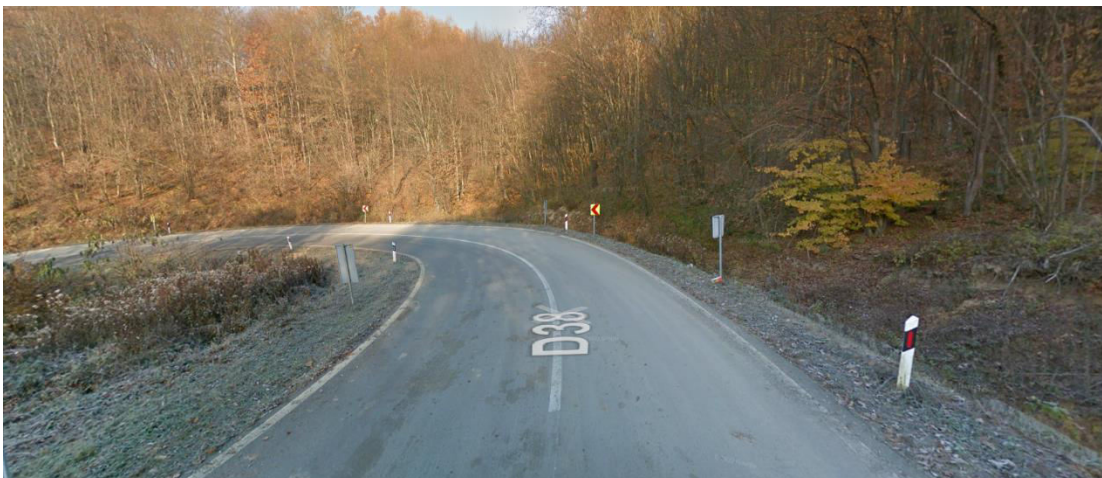
Slika 25: Prikaz lokacije za provođenje mjera za povećanje sigurnosti motociklista na DC38
