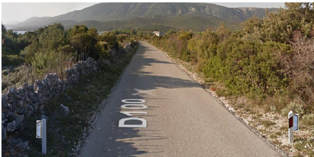
Slika 35: Prikaz smjerokaznih stupića s reflektorom za odvracanje divljači
