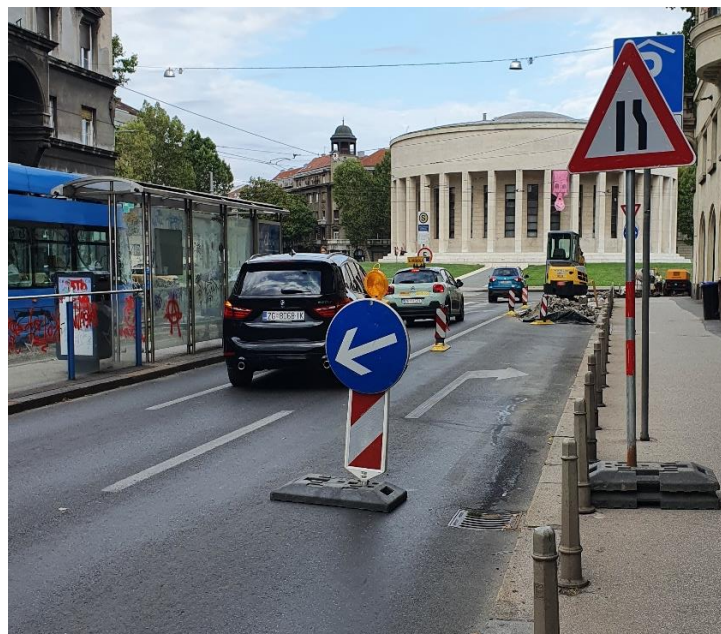
Slika 65. Prometna signalizacija na mjestu radova
