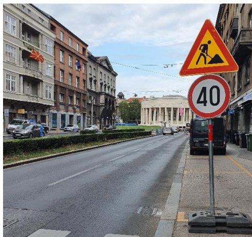
Slika 63. Znak opasnosti "Radovi na cesti" (A15) i znak izričitih naredbi "Ograničenje brzine" (B30)
