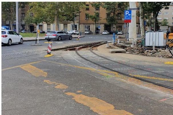
Slika 68. Radovi na izmjeni kolosijeka u samome križanju
