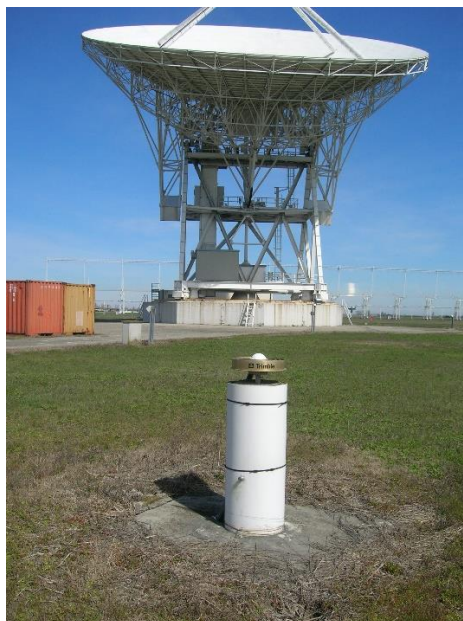
Slika 18. Bazna stanica u Medici
