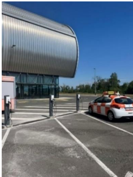
Slika 18. Postaja za punjenje električnom energijom Follow me vozila - Zračna luka Franjo Tuđman
