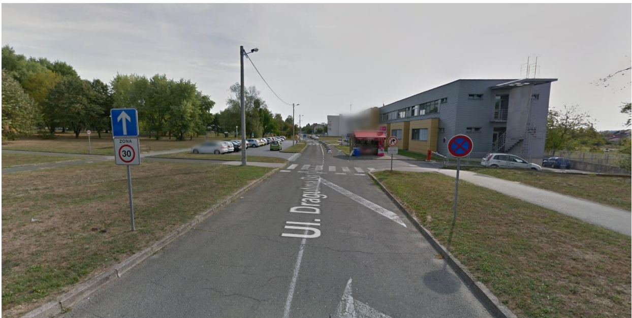
Slika 12. Ulica Dragutina Domjanića prije rekonstrukcije
