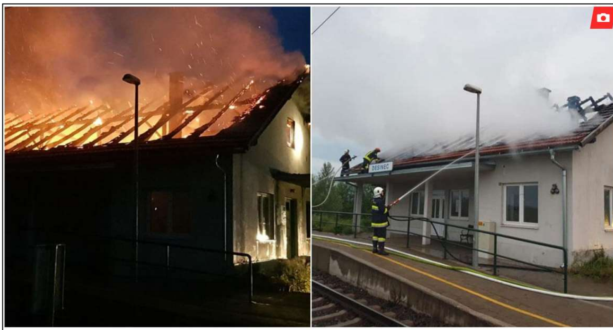
Slika 18: Požar zgrade željezničke stanice u Desincu
