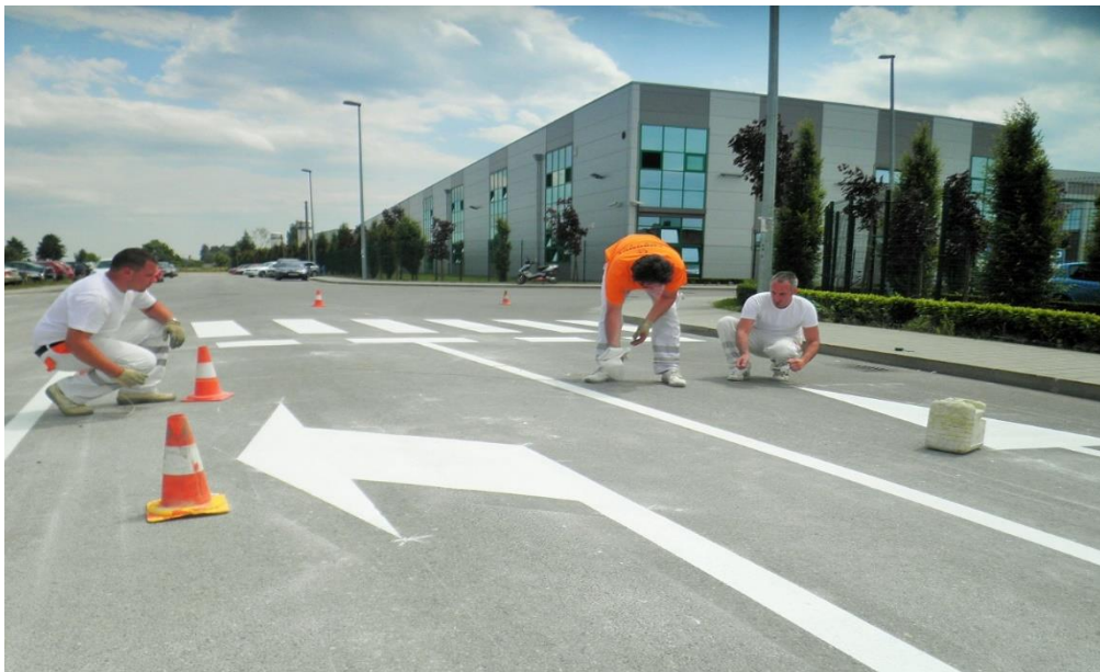
Slika 8. Radovi na uređenju horizontalne signalizacije Izvor: https://zelenilo.hr/odrzavanje-horizontalne-signalizacije-2/
