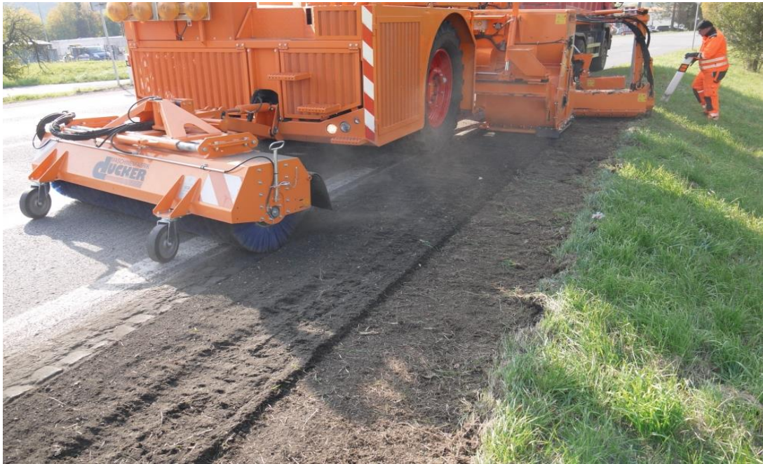
Slika 6. Strojno uređenje bankina
