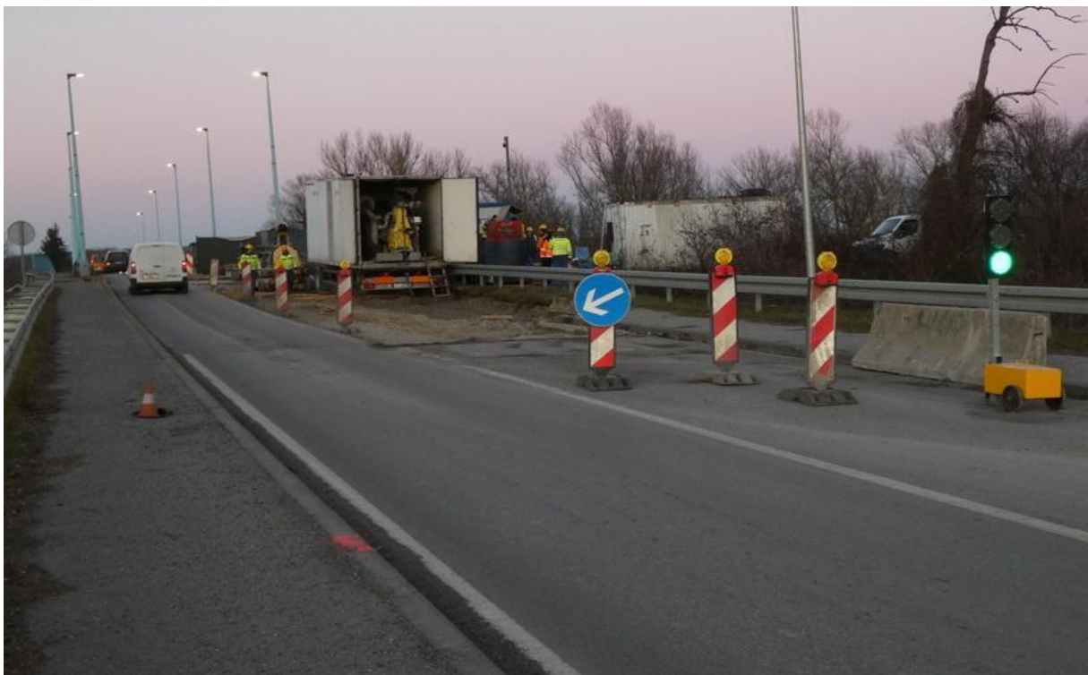
Slika 11. Zamjena kolnika na mostu Brest
