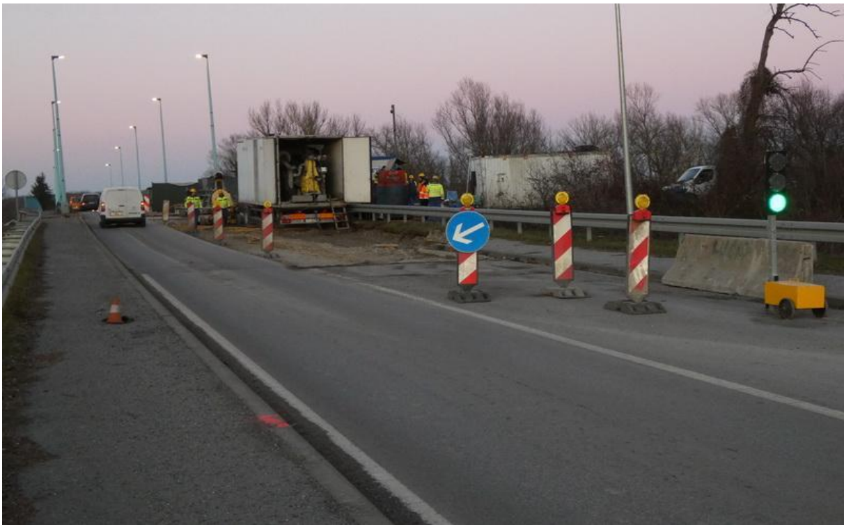
Slika 11. Zamjena kolnika na mostu Brest
