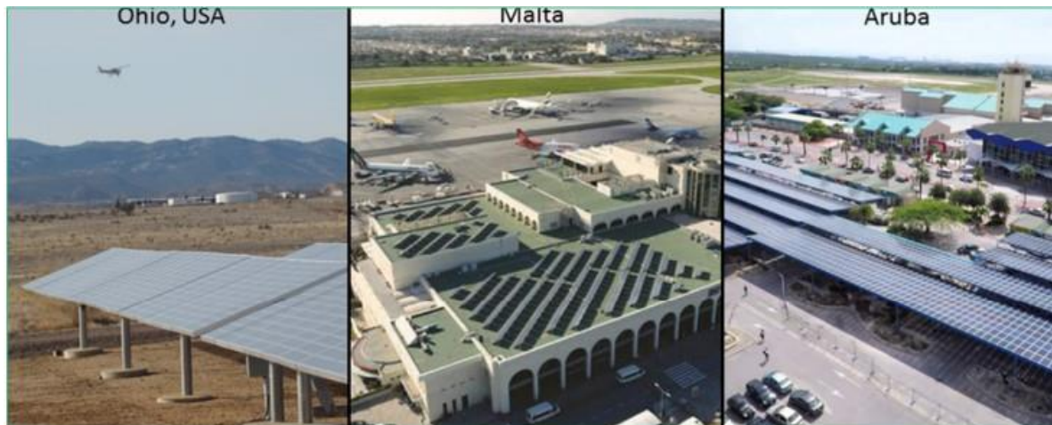
Slika 2. Primjena solarnih panela na zračnim lukama, (1)
