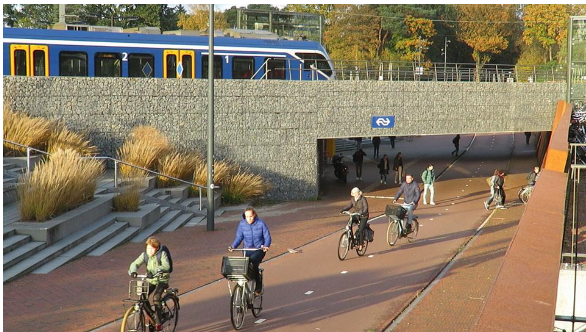
Slika 46 Primjer pješačko-biciklističkog pothodnika izgrađenog u Nizozemskoj [26]
