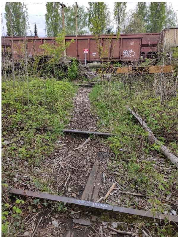
Slika 16 Lokacija 2 – „divlji“ prijelaz [24]
