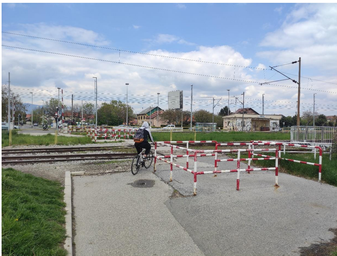
Slika 35 Kretanje uz mimoilaznu zaštitnu ogradu na prijelazu preko pruge - primjer 1 [24]
