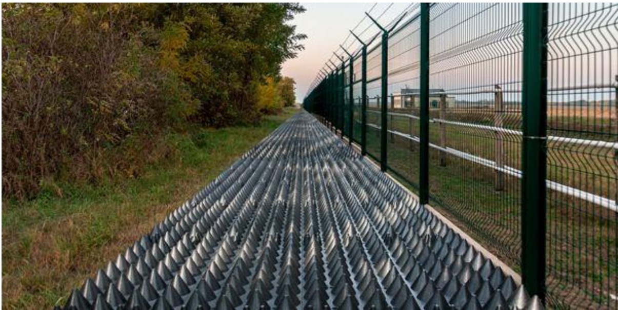
Slika 59 Primjer "anti-trespass" panela u kombinaciji sa zaštitnom ogradom [32]
