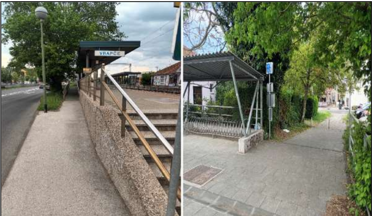
Slika 29. Rampa R1 (lijevo) i rampa R2 (desno)
