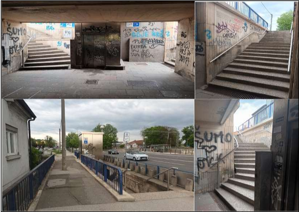
Slika 30. Ulaz/izlaz broj 1 pothodnika na zapadnoj lokaciji
