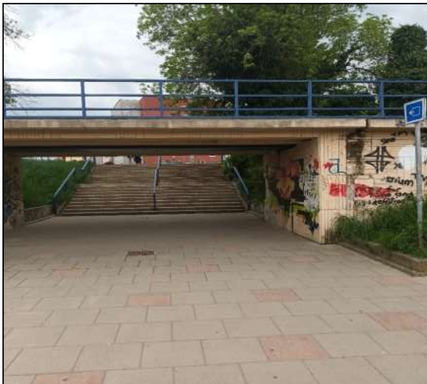
Slika 33. Ulaz/izlaz broj 4 pothodnika na zapadnoj lokaciji
