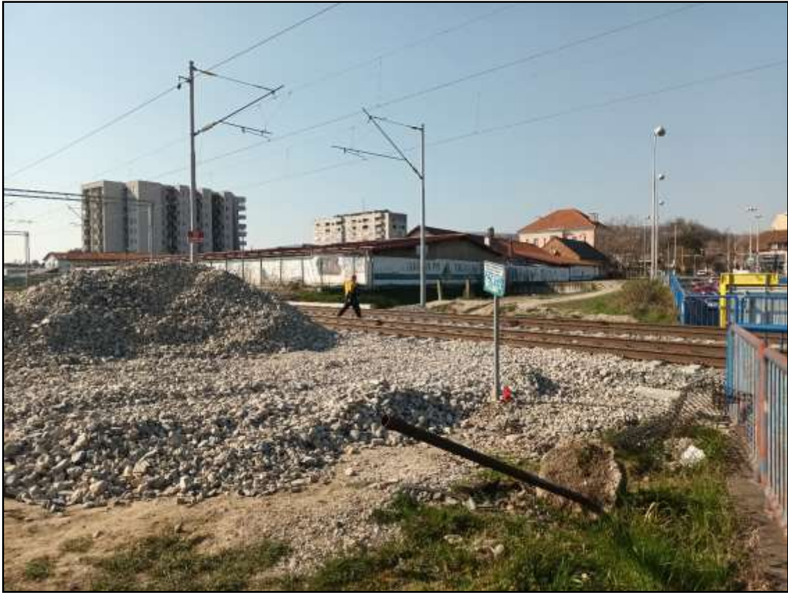
Slika 8. Terenski prikaz mikrolokacije broj 2 – pogled s jugoistoka, zapadno od ulice Oranice
