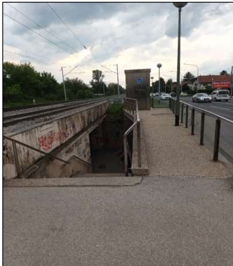
Slika 31. Ulaz/izlaz broj 2 pothodnika na zapadnoj lokaciji
