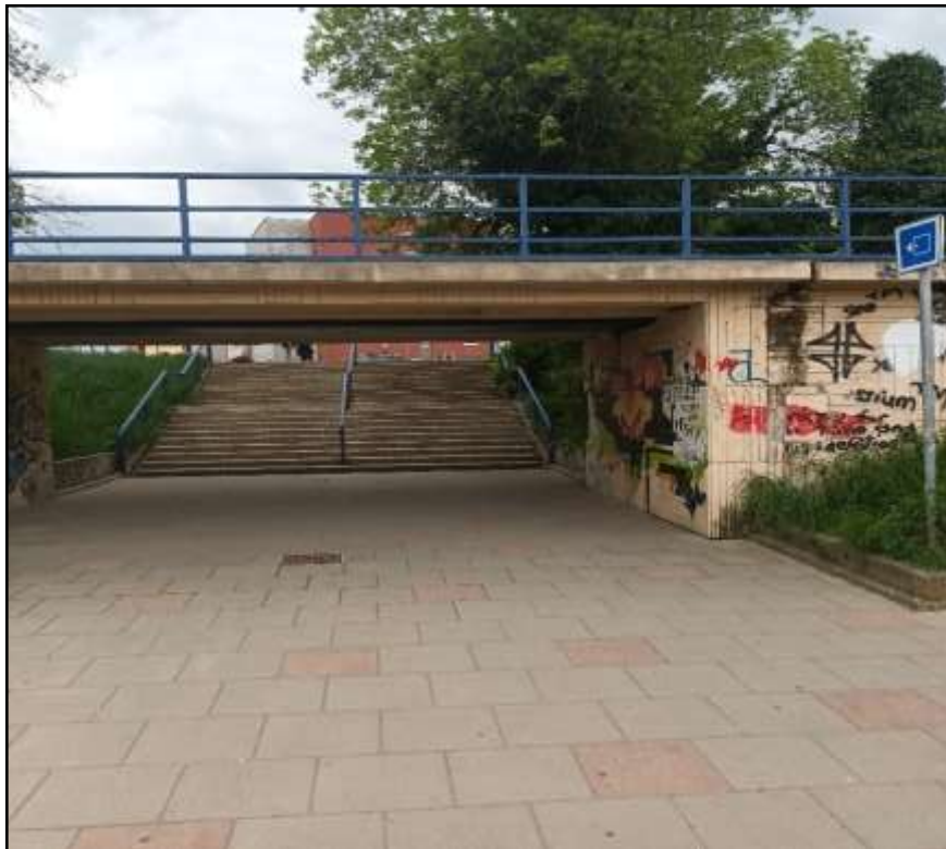
Slika 33. Ulaz/izlaz broj 4 pothodnika na zapadnoj lokaciji
