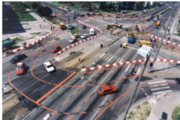
Slika 16: Oznake na kolniku izvedene trakama narančaste boje
