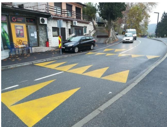
Slika 17. Uspornik na Zagrebačkoj ulici
