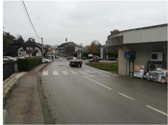
Slika 16. Pješački prijelaz u Topličkoj ulici
