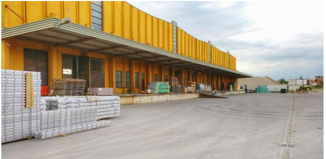
Slika 20. PeveX d.d. – Centralno skladište
