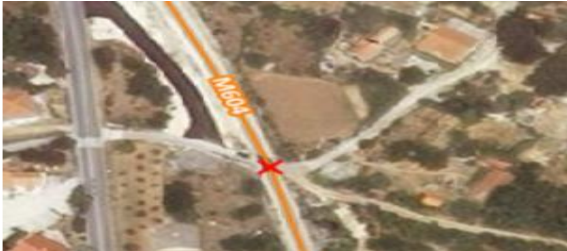
Slika 32. Željezničko-cestovni prijelaz „Runjići“
