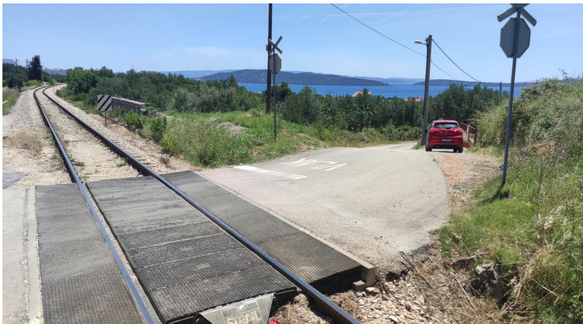
Slika 61. Željezničko-cestovni prijelaz „Kaštel Lukšić“ iz smjera istoka
