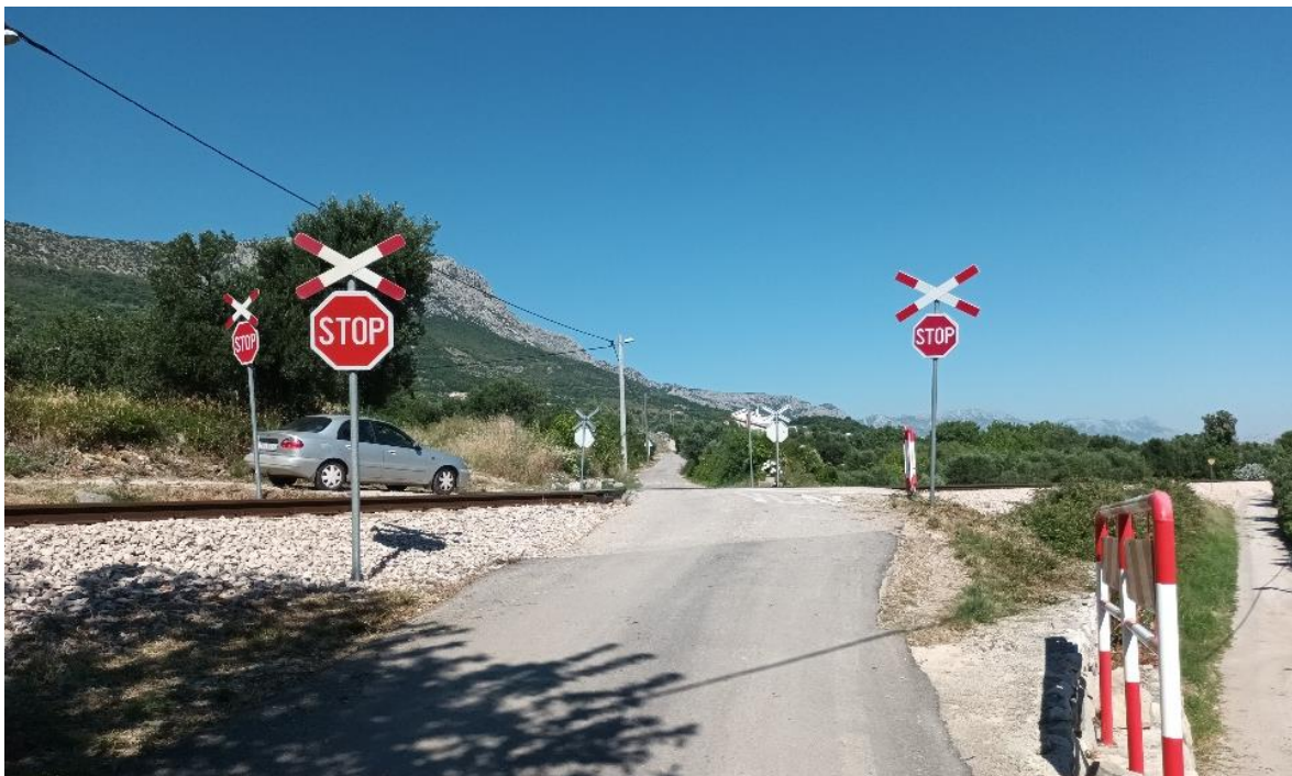
Slika 66. Željezničko-cestovni prijelaz „Kaštel Lukšić mali“ iz smjera zapada
