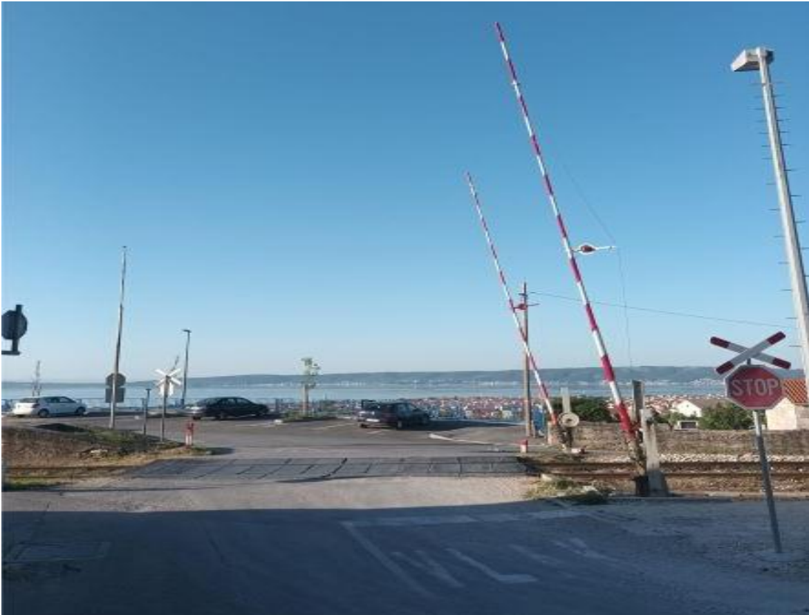
Slika 49. Željezničko-cestovni prijelaz „Kaštel Stari 1“ iz smjera istoka Izvor: Autor
