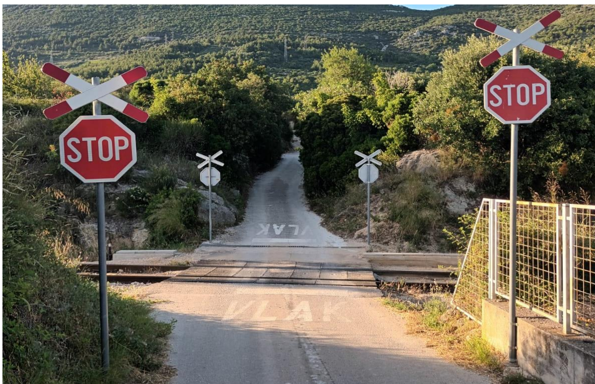
Slika 57. Željezničko-cestovni prijelaz „Kaštel Stari.“ iz smjera istoka
