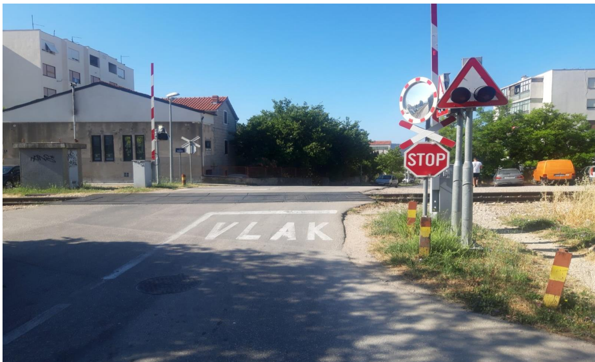
Slika 4. Željezničko-cestovni prijelaz osiguran sa svjetlosno-zvučnom signalizacijom polubranicima , Kaštel Sućurac 1 Izvor: Autor
