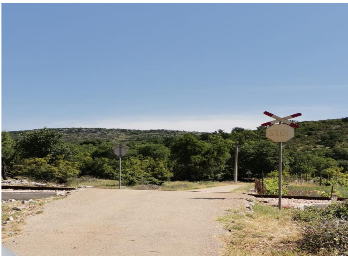
Slika 17. Željezničko-cestovni prijelaz „Balovljev“ iz smjera zapada
