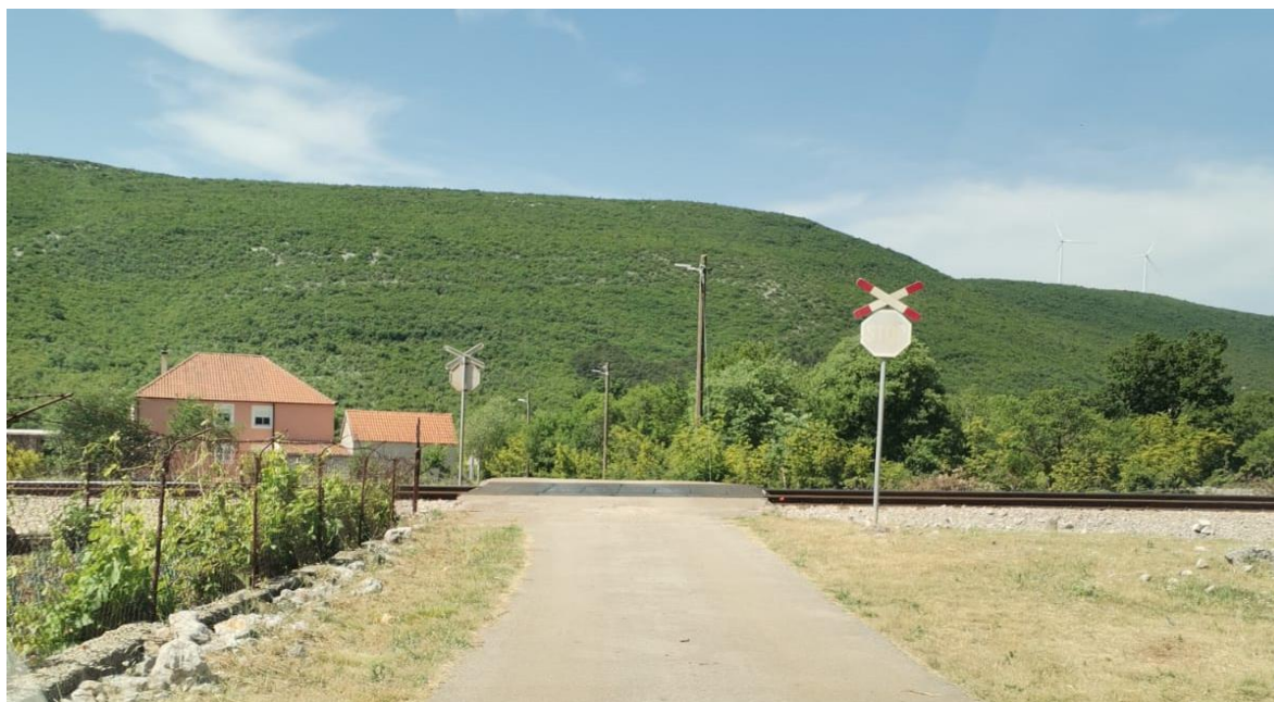
Slika 16. Željezničko-cestovni prijelaz „Balovljev“ iz smjera istoka
