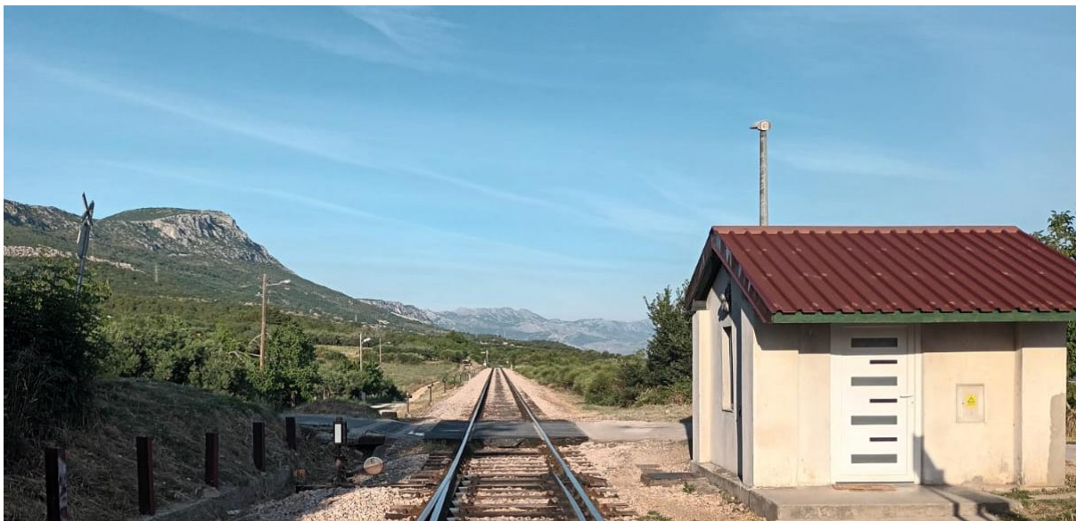
Slika 55. Prikaz stanja gumirane podloge na željezničko-cestovnom prijelazu „Kaštel Stari 2“
