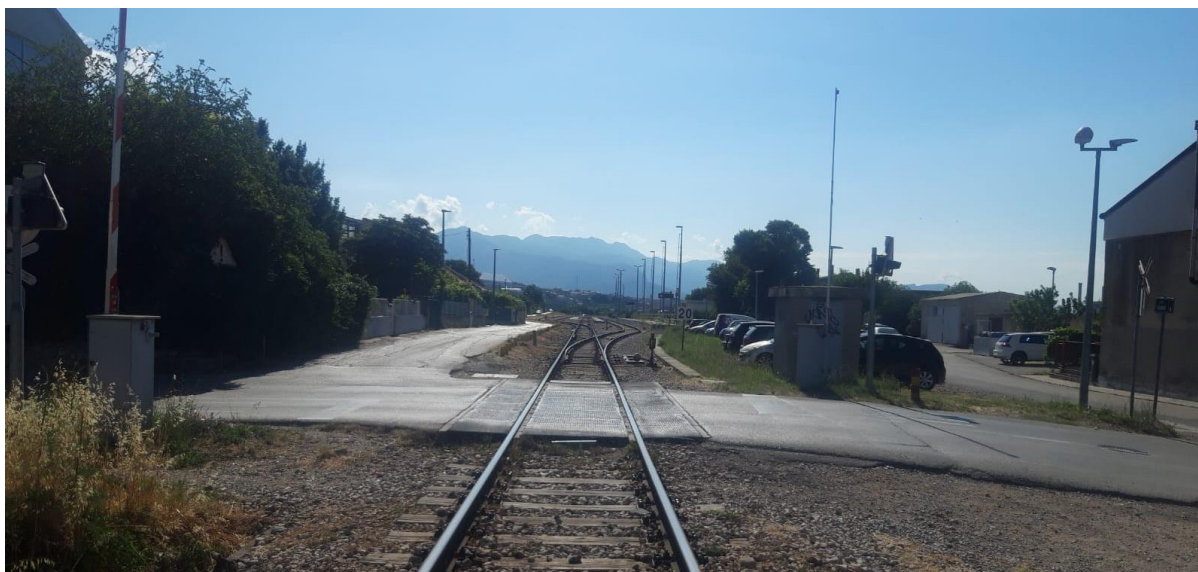
Slika 79. Prikaz stanja gumirane podloge na željezničko-cestovnom prijelazu „Kaštel Sućurac“
