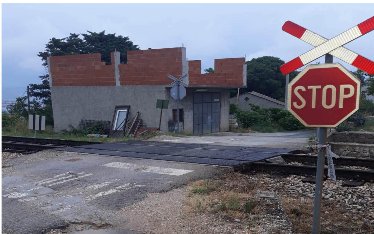
Slika 45. Željezničko-cestovni prijelaz „Trečanica“ iz smjera istoka
