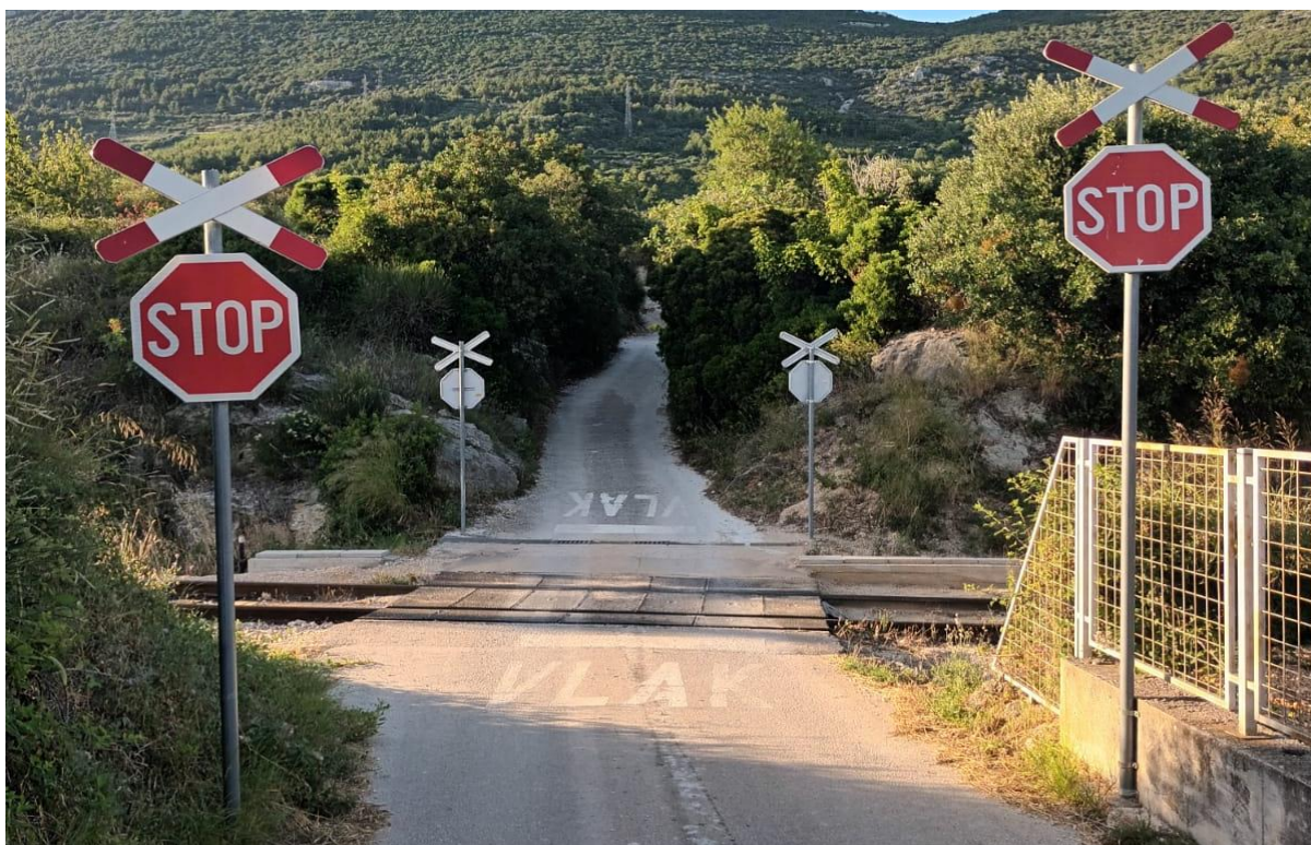
Slika 57. Željezničko-cestovni prijelaz „Kaštel Stari.“ iz smjera istoka
