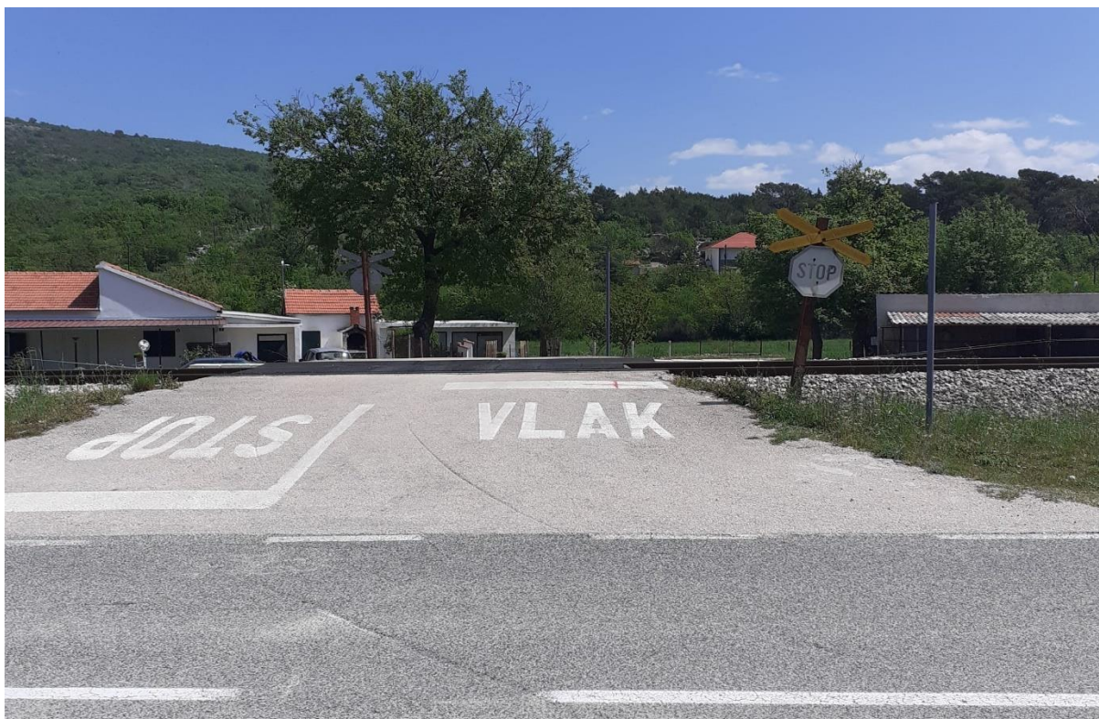
Slika 38. Željezničko-cestovni prijelaz „Labin“ iz smjera zapad
