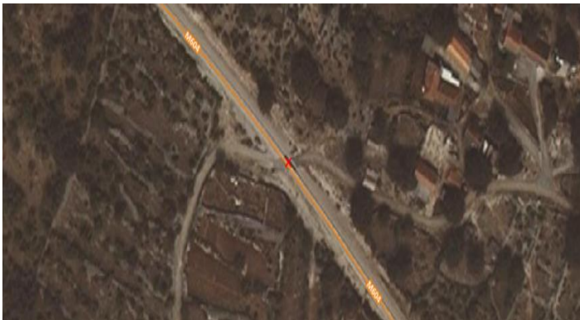
Slika 11. Željezničko-cestovni prijelaz „Perlić“
