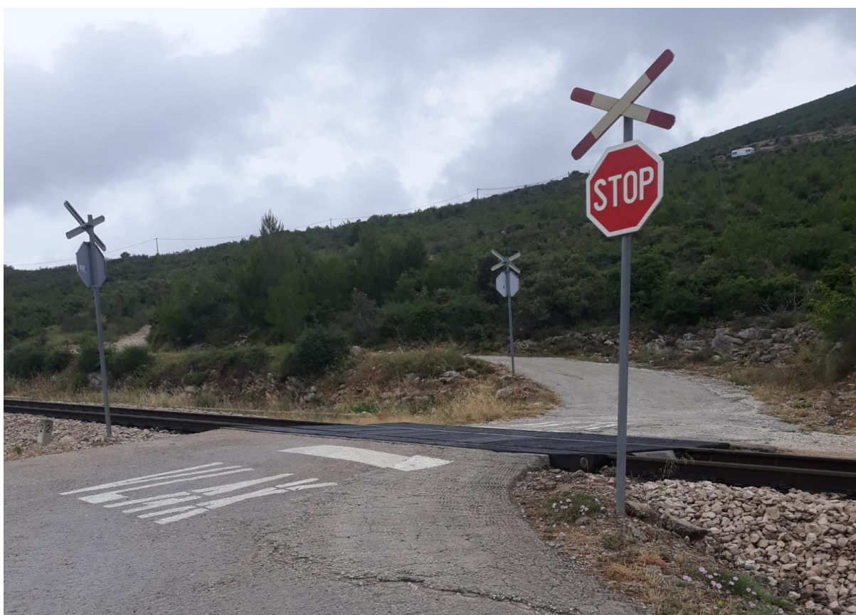
Slika 42. Željezničko-cestovni prijelaz „Sadine“ iz smjera zapada Izvor: Autor
