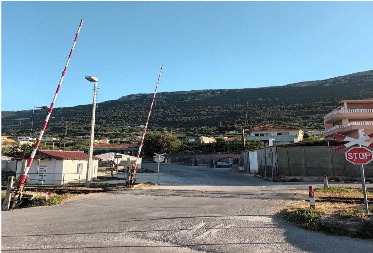
Slika 5. Željezničko-cestovni prijelaz osiguran punim branicima, Kaštel Stari 1
