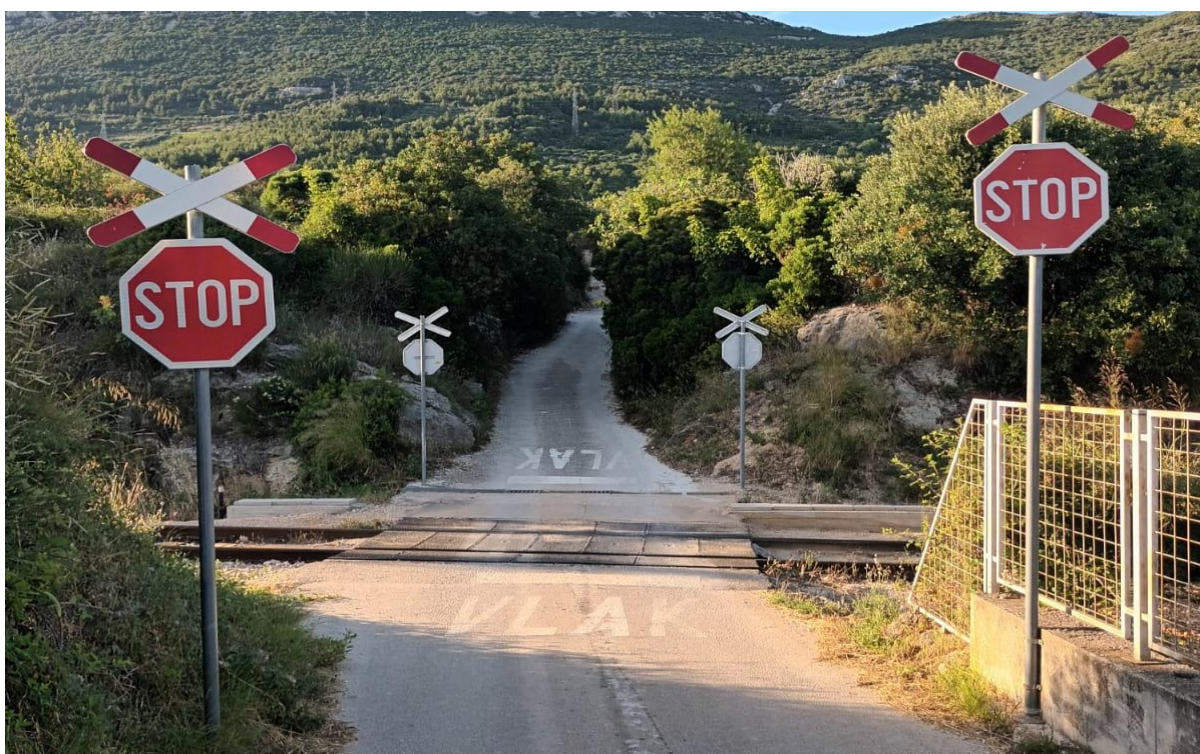
Slika 58. Željezničko-cestovni prijelaz „Kaštel Stari“ iz smjera zapada
