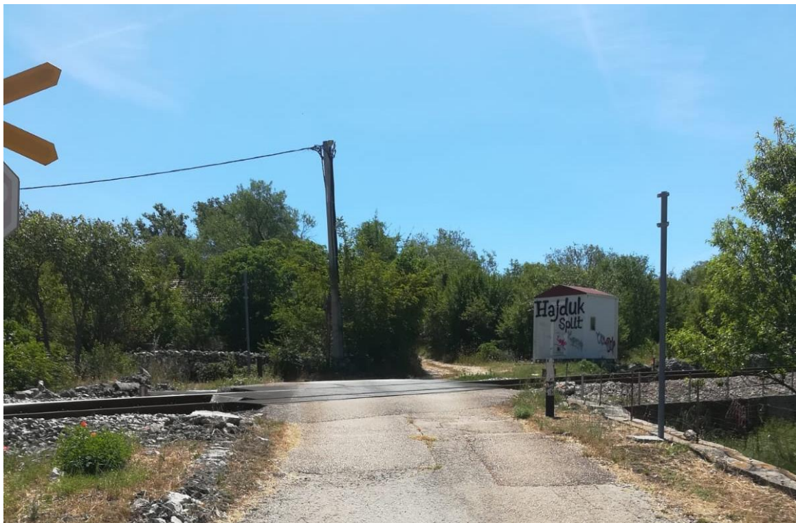
Slika 33. Željezničko-cestovni prijelaz „Runjići“ iz smjera istoka
