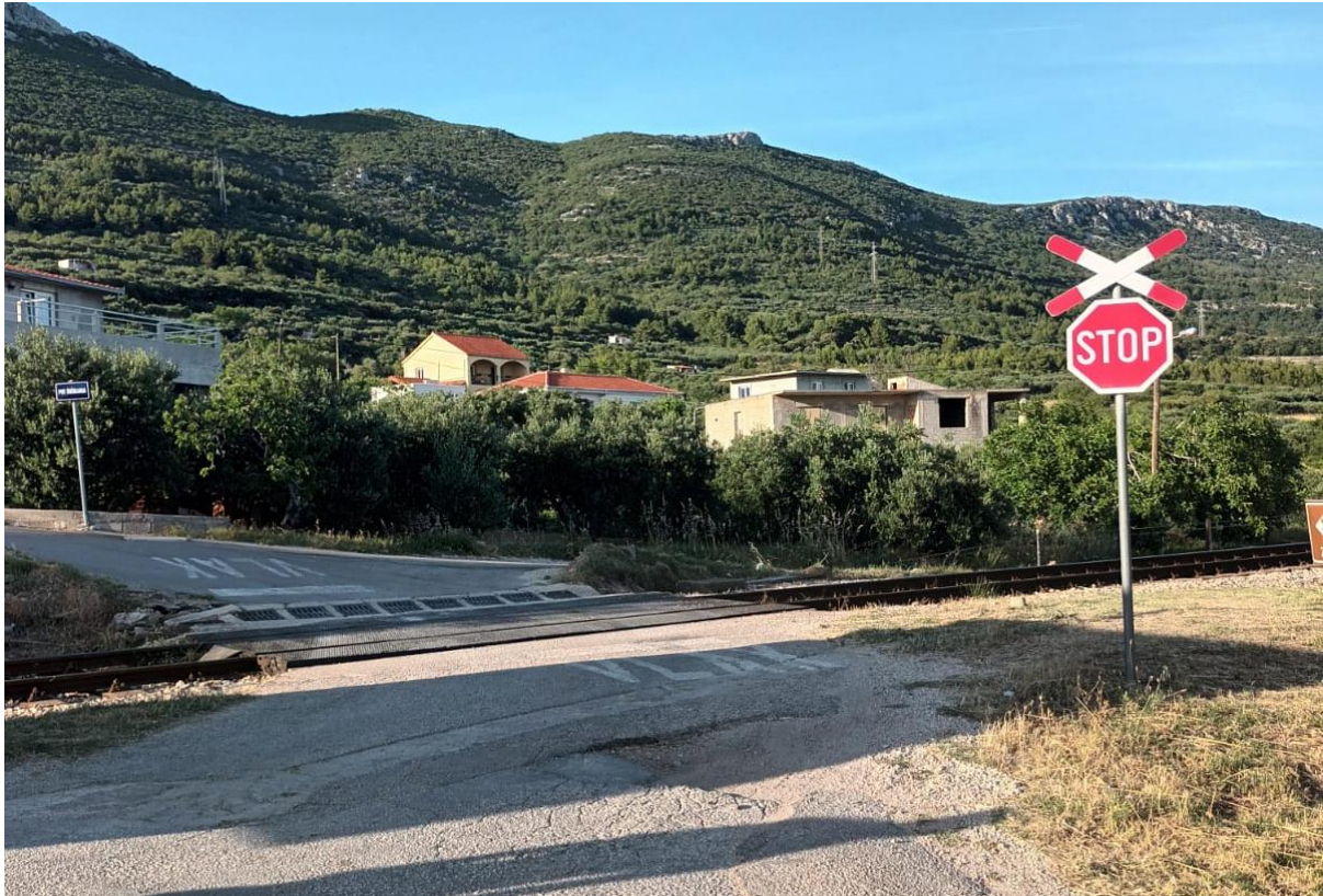
Slika 54. Željezničko-cestovni prijelaz „Kaštel Stari 2“ iz smjera zapada
