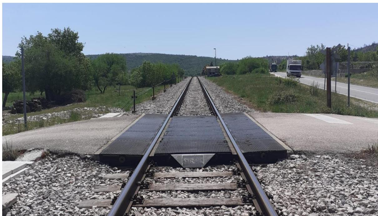
**Slika 39. Prikaz stanja gumiranih ploča na željezničko-cestovnom prijelazu „Labin“**
