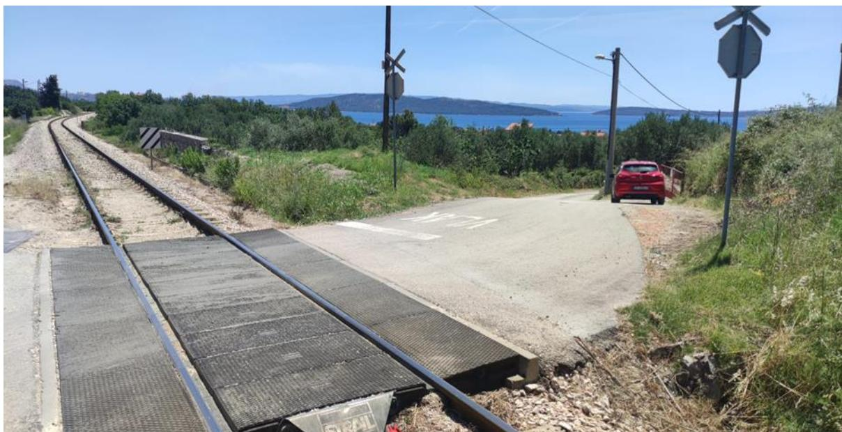
**Slika 63. Prikaz stanja gumirane podloge na željezničko-cestovnom prijelazu „Kaštel Lukšić“**
