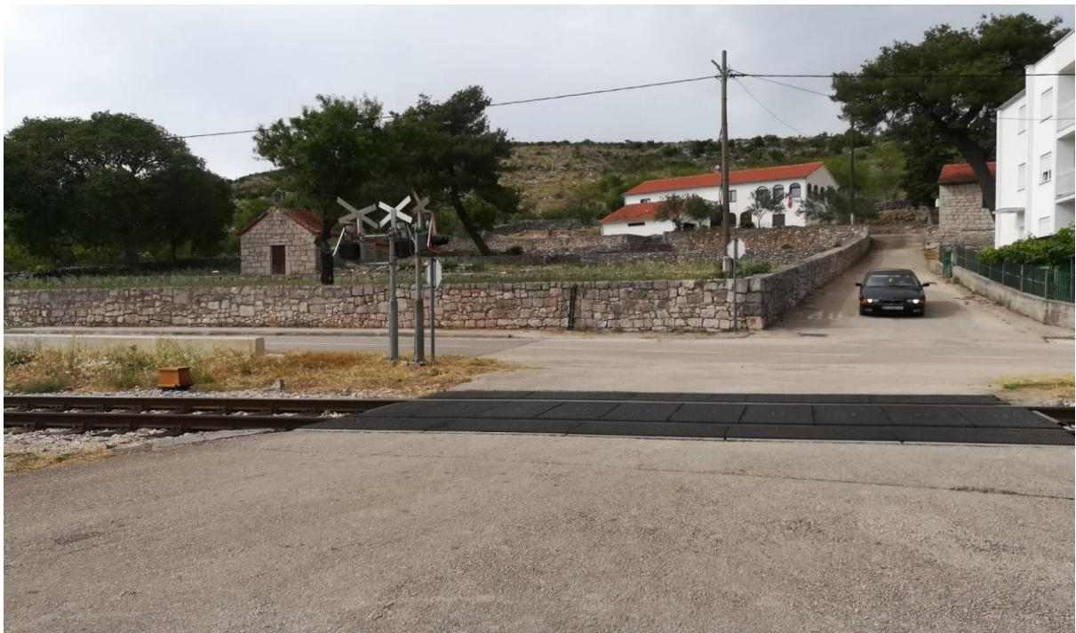
**Slika 31. Prikaz stanja gumiranih ploča na željezničko-cestovnom prijelazu „Fratrov“**
