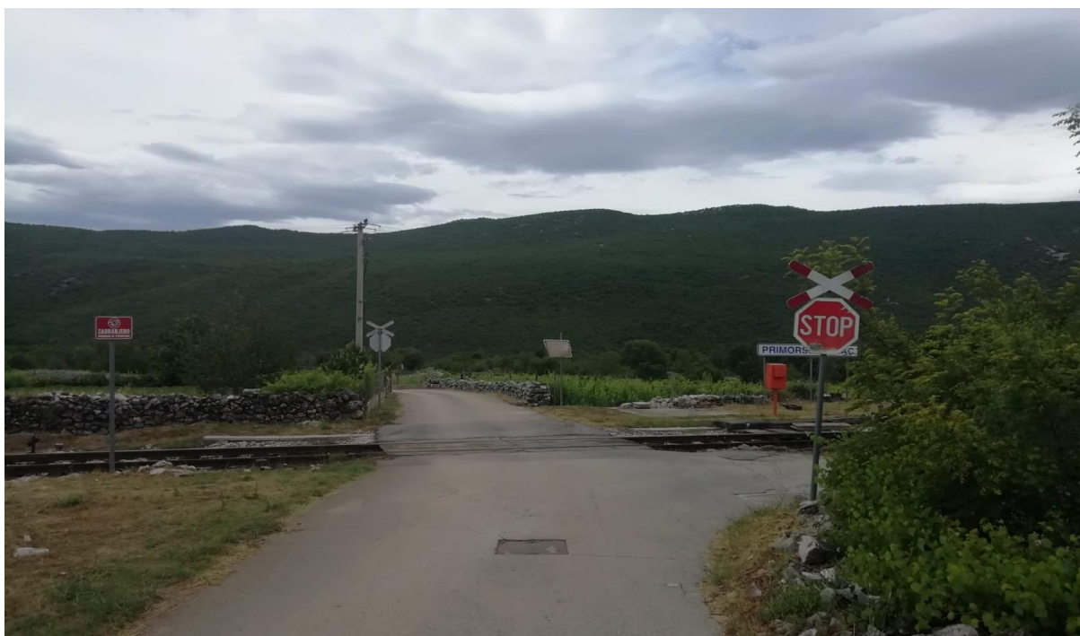
Slika 20. Željezničko-cestovni prijelaz „Stojaci“ iz smjera istoka
