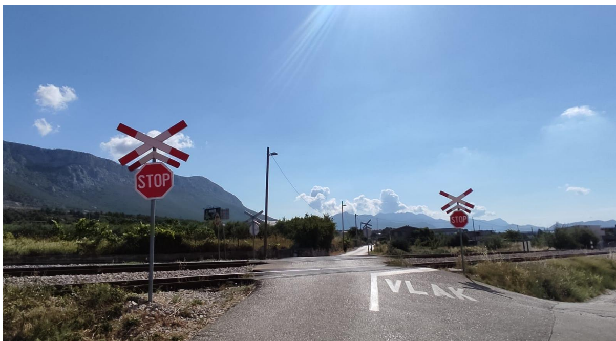
Slika 82. Željezničko-cestovni prijelaz „Kaštel Sućurac II“ iz smjera zapada
