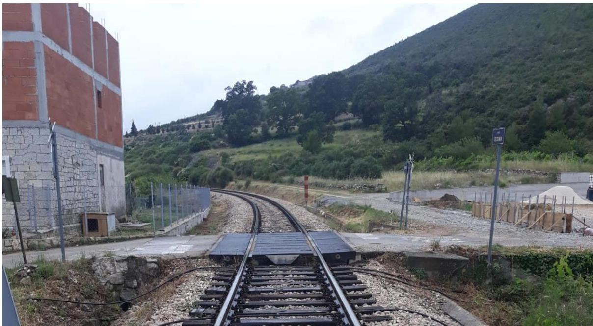
*Slika 47. Prikaz stanja gumirane podloge na željezničko-cestovnom prijelazu „Trećanica“*
