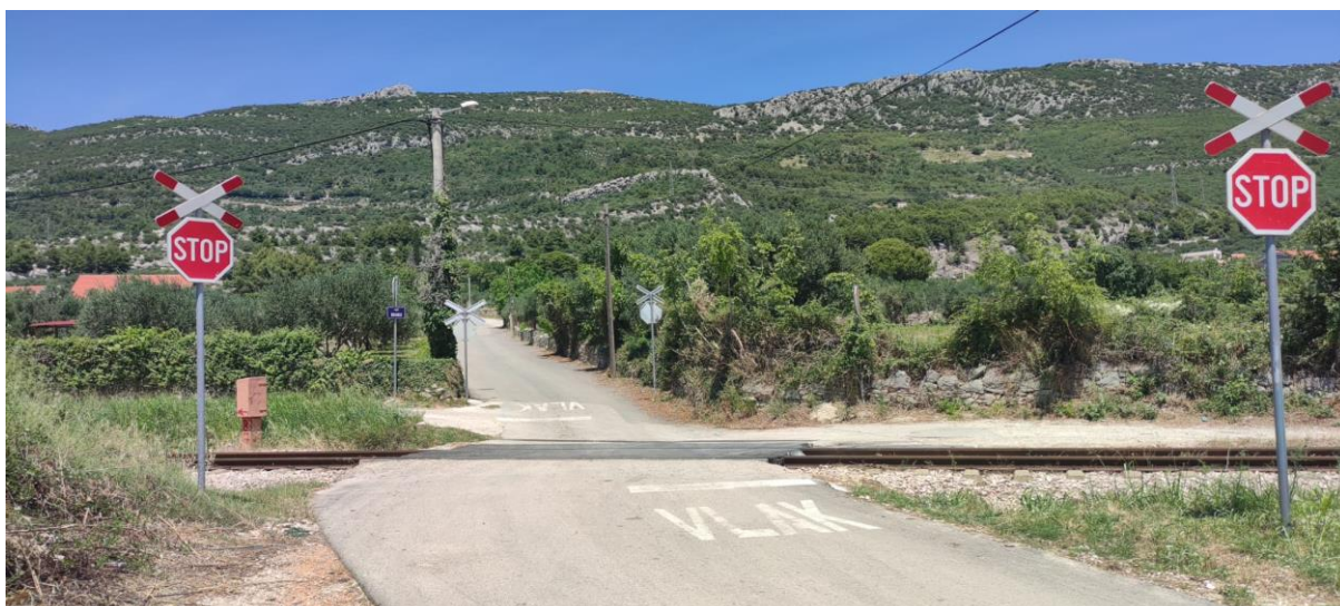
Slika 62. Željezničko-cestovni prijelaz „Kaštel Lukšić“ iz smjera zapada
