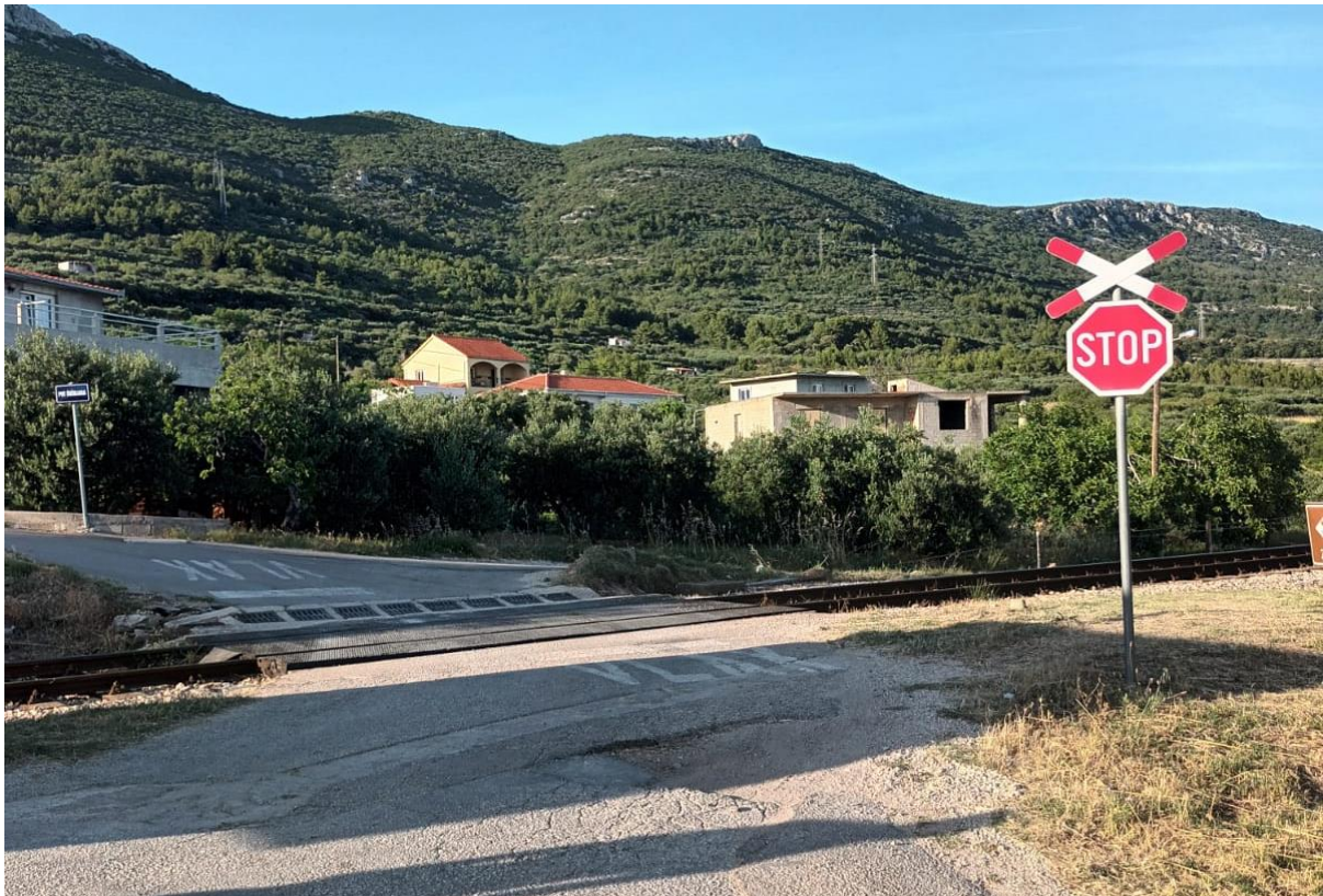
Slika 54. Željezničko-cestovni prijelaz „Kaštel Stari 2“ iz smjera zapada
