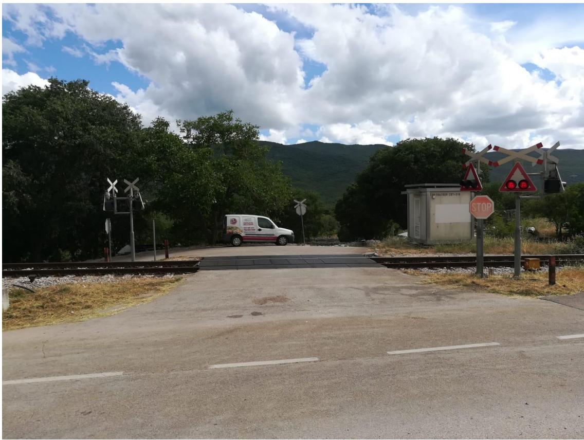
**Slika 3. Željezničko-cestovni prijelaz osiguran sa svjetlosno-zvučnom signalizacijom i "Andrijinim križem",
