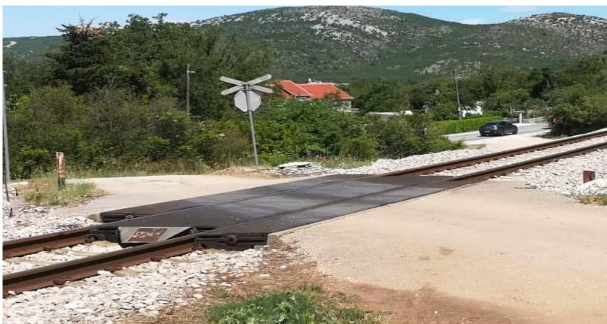
*Slika 35. Prikaz stanja gumiranih ploča na željezničko-cestovnom prijelazu „Runjići“*
