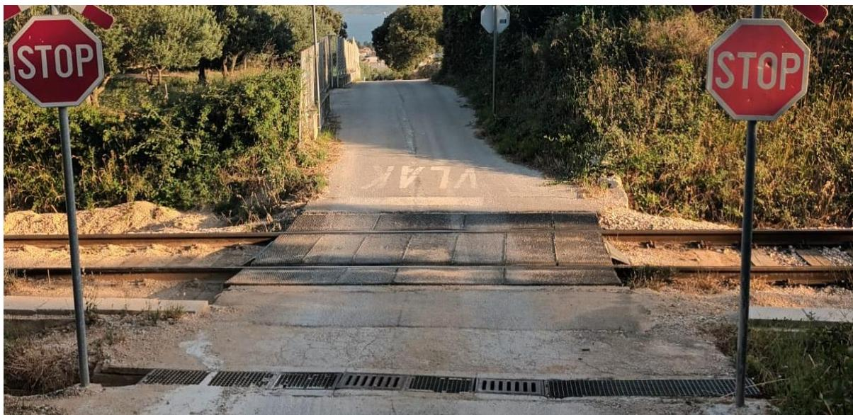
**Slika 59. Prikaz stanja gumirane podloge na željezničko-cestovnom prijelazu „Kaštel Stari“**
