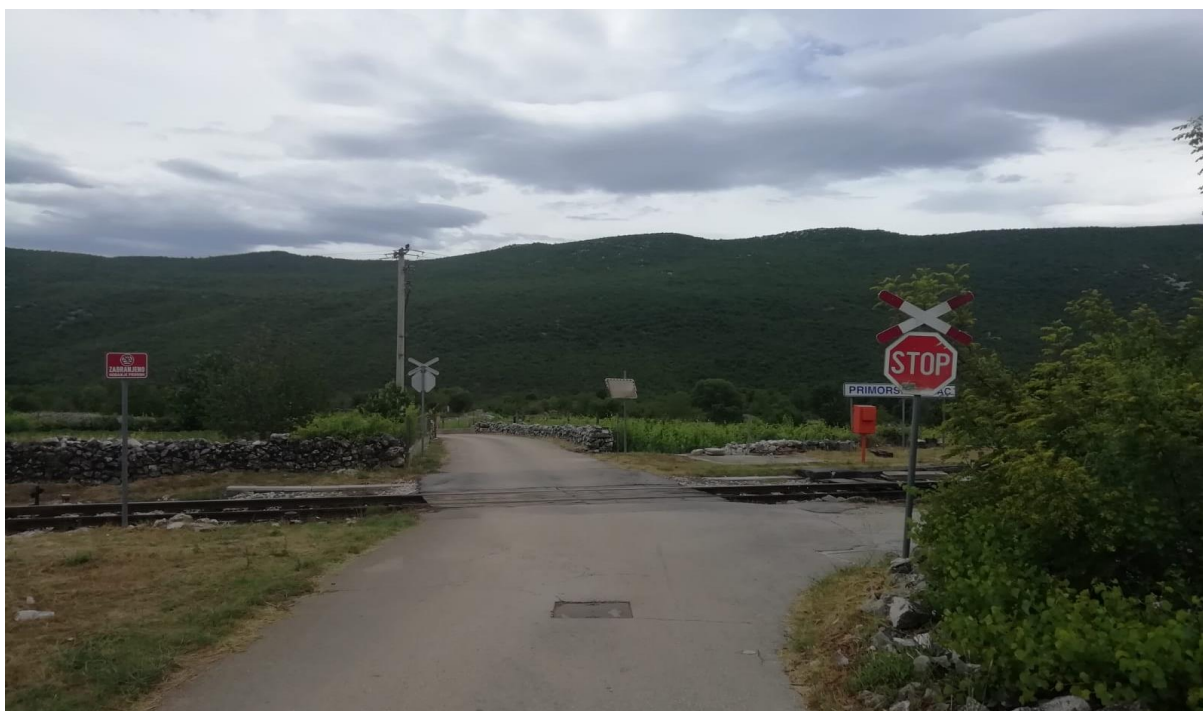
Slika 20. Željezničko-cestovni prijelaz „Stojaci“ iz smjera istoka
