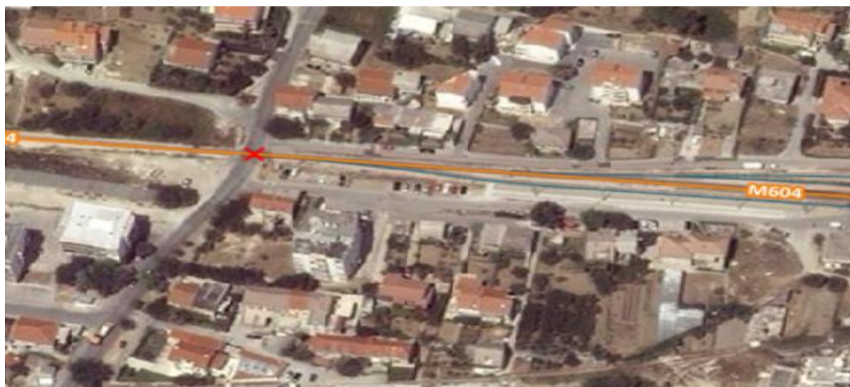
Slika 76. Željezničko-cestovni prijelaz „Kaštel Sućurac“
