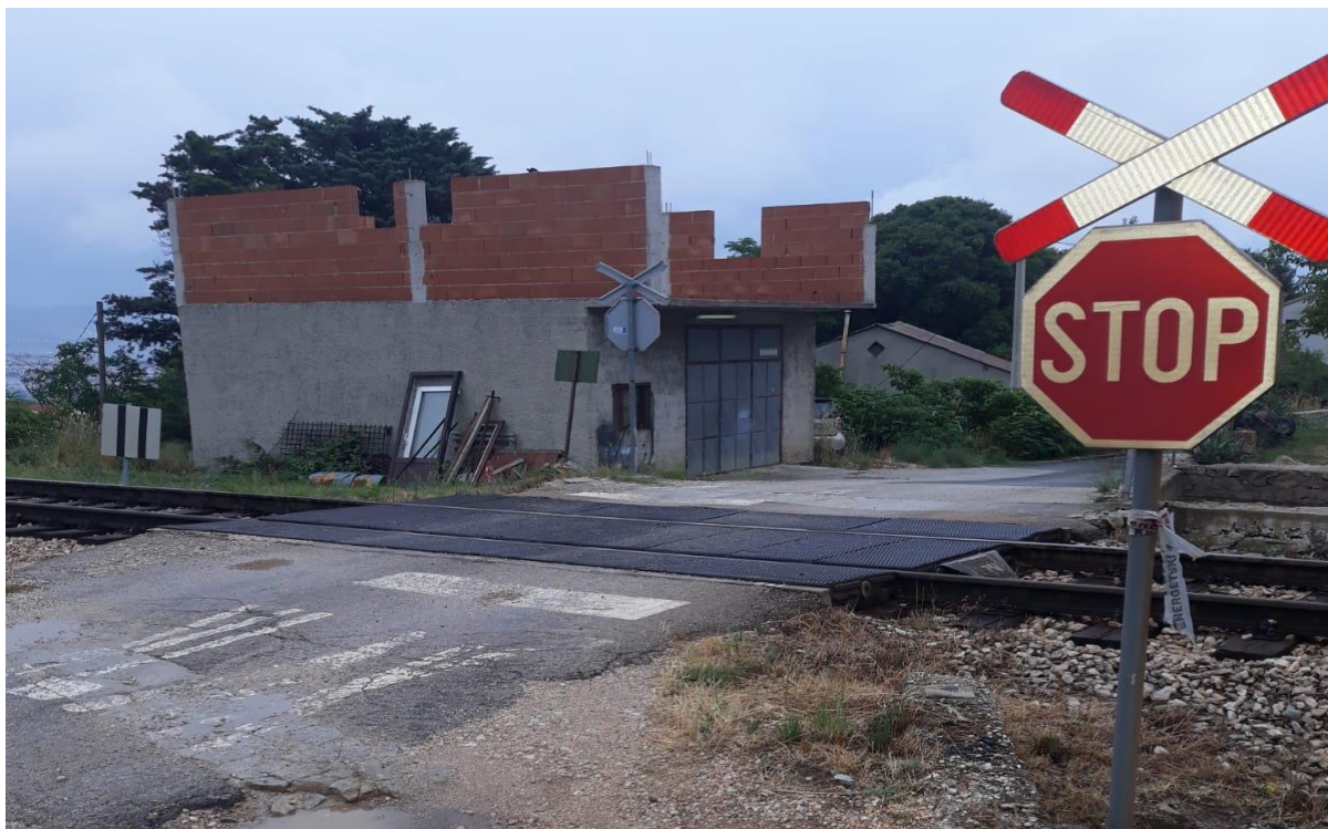
Slika 45. Željezničko-cestovni prijelaz „Trečanica“ iz smjera istoka
