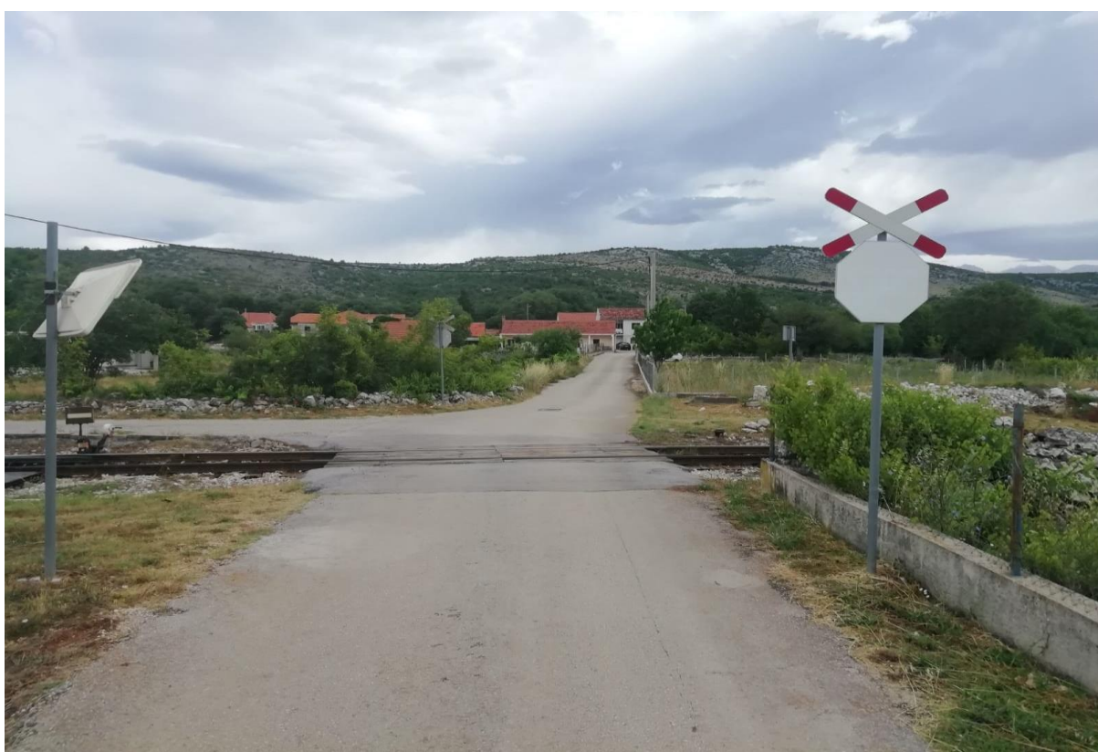
Slika 21. Željezničko-cestovni prijelaz „Stojaci“ iz smjera zapada
