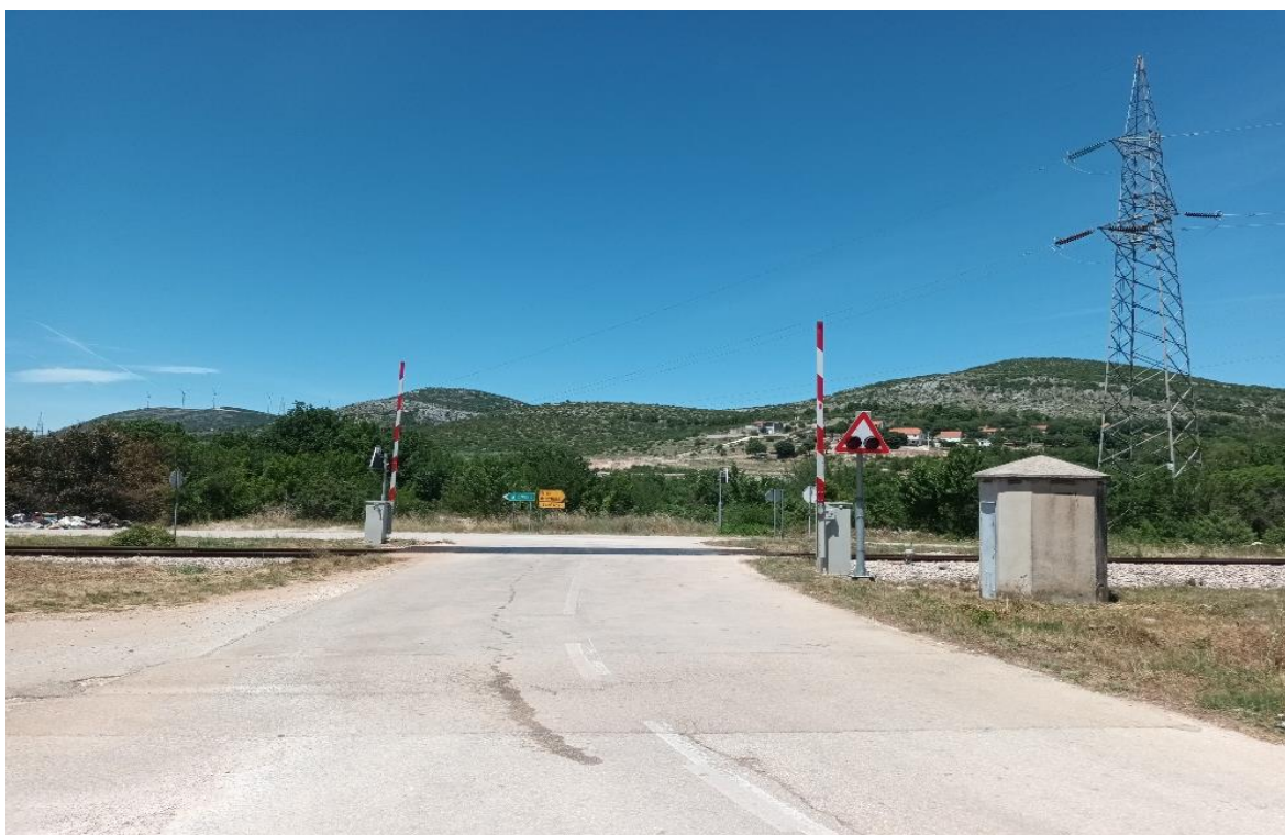
Slika 8. Željezničko-cestovni prijelaz „Perković“ iz smjera istoka
