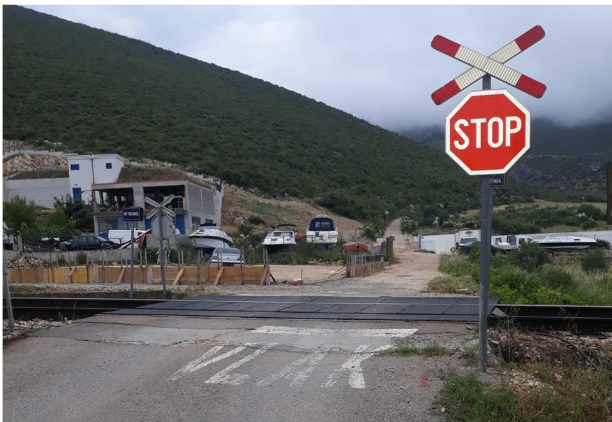
Slika 46. Željezničko-cestovni prijelaz „Trečanica“ iz smjera zapada
