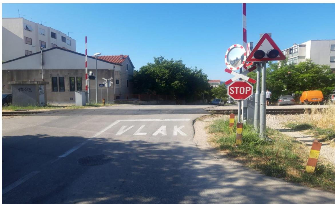
**Slika 4. Željezničko-cestovni prijelaz osiguran sa svjetlosno-zvučnom signalizacijom polubranicima , Kaštel
