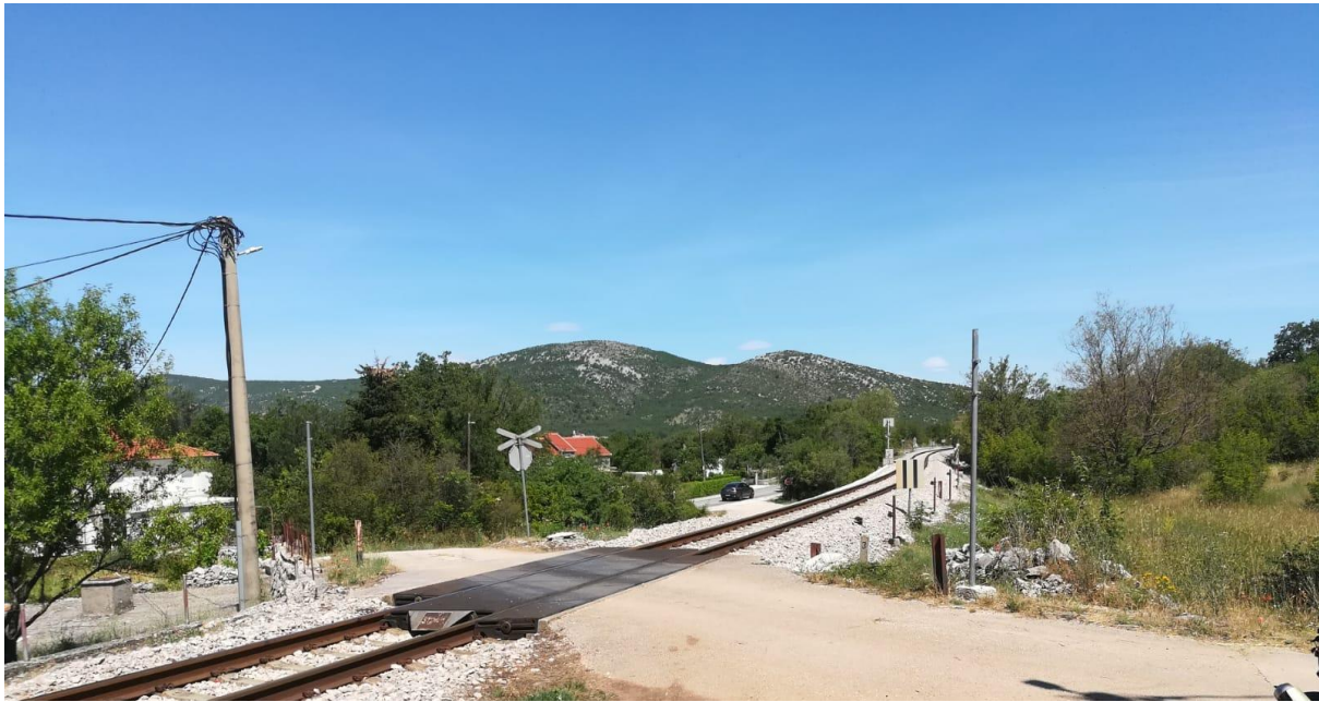
Slika 34. Željezničko-cestovni prijelaz „Runjići“ iz smjera zapada
