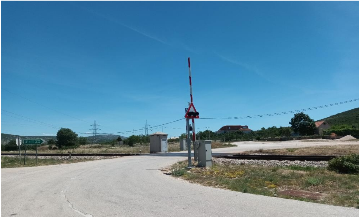
Slika 9. Željezničko-cestovni prijelaz „Perkovići“ iz smjera zapada
