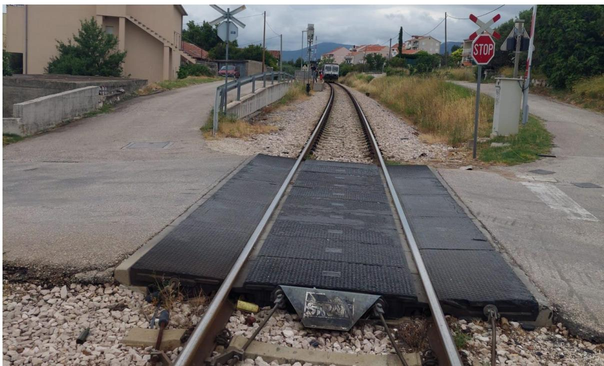
**Slika 71. Prikaz stanja gumirane podloge na željezničko-cestovnom prijelazu „Kaštel Gomilica“**
