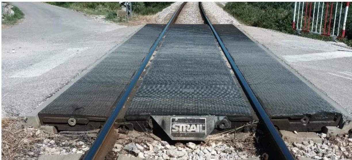
*Slika 67. Prikaz stanja gumirane podloge na željezničko-cestovnom prijelazu „Kaštel Lukšić“*
