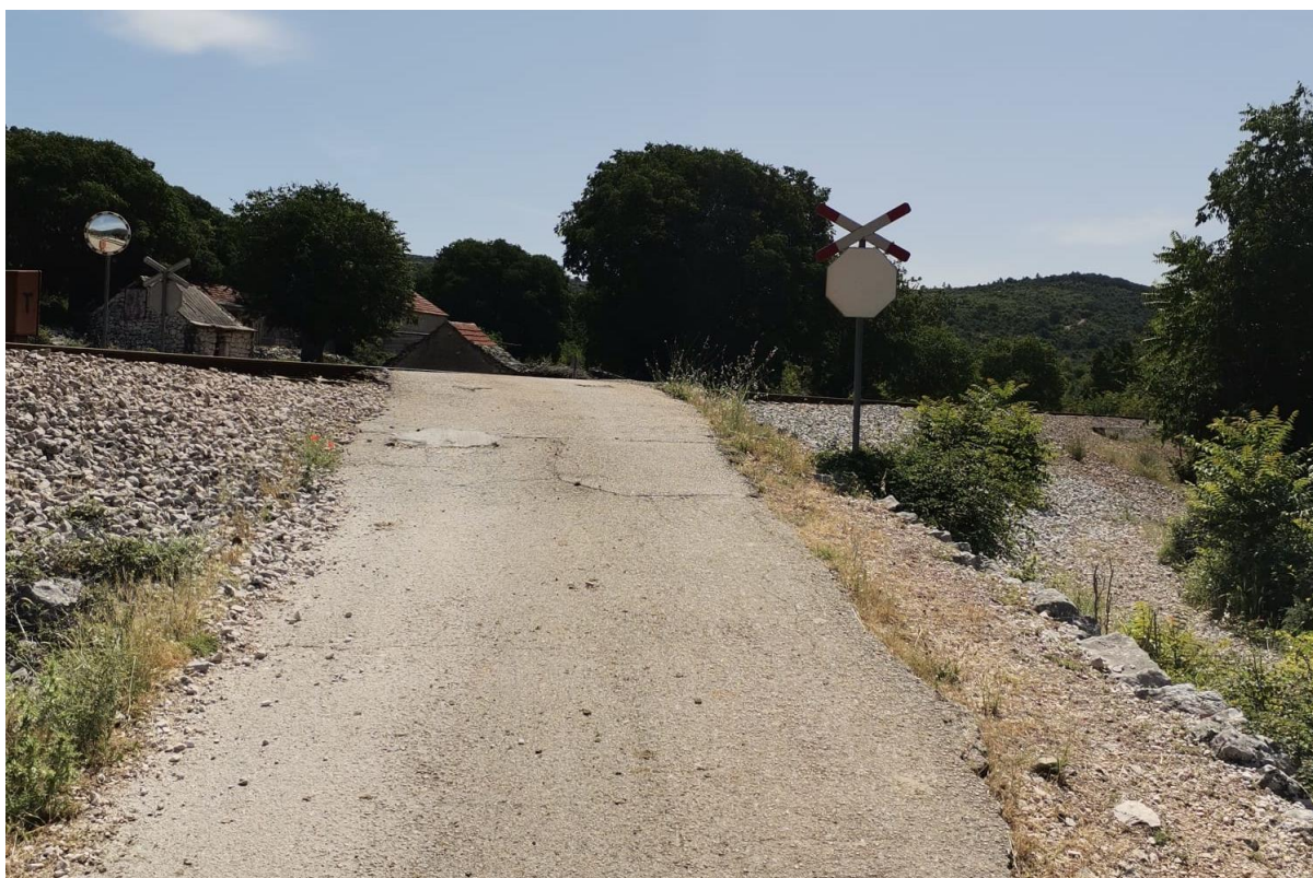
Slika 13. Željezničko-cestovni prijelaz „Perlić“ iz smjera zapada
