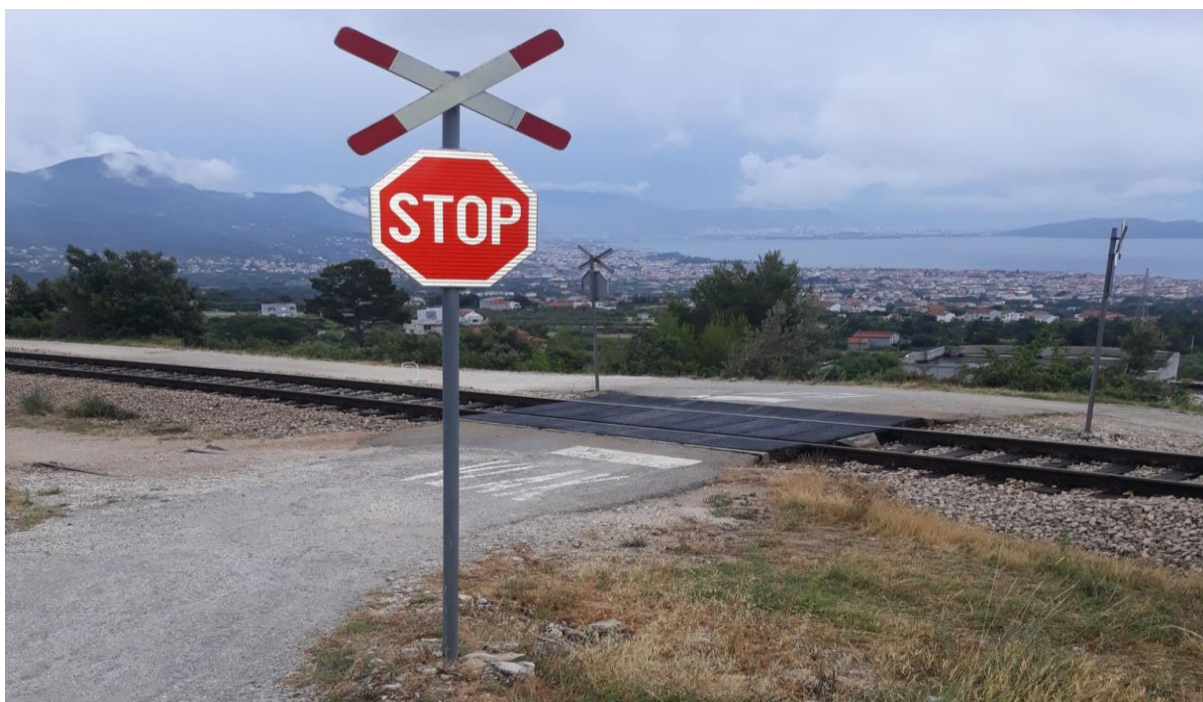
Slika 41. Željezničko-cestovni prijelaz „Sadine“ iz smjera istoka Izvor: Autor
