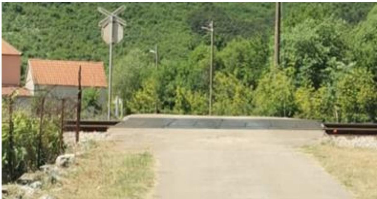
*Slika 18. Prikaz stanja gumiranih ploča na željezničko-cestovnom prijelazu „Balovljev“*
