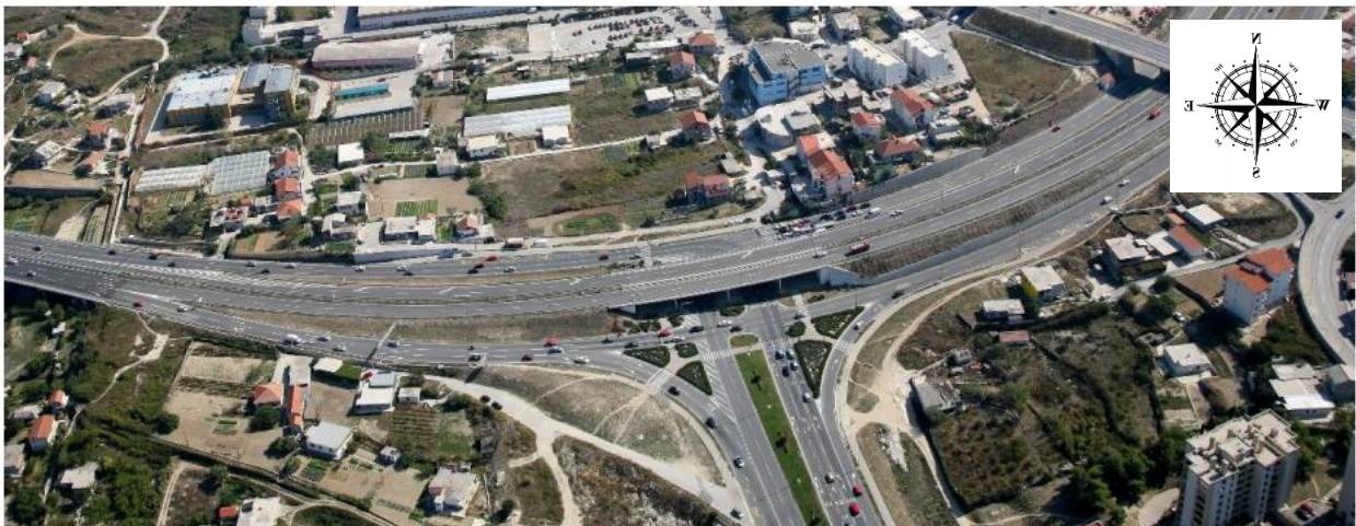
Slika 14. Raskrižje Ulice Zborna narodne garde i Ulice Domovinskog rata u Splitu [25]
