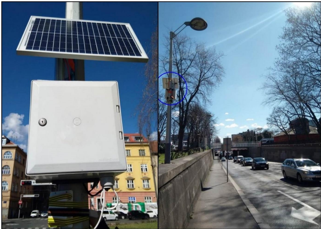
Slika 6. Prikaz BT detektora i lokacija BT detektora u odnosu na prometnicu
