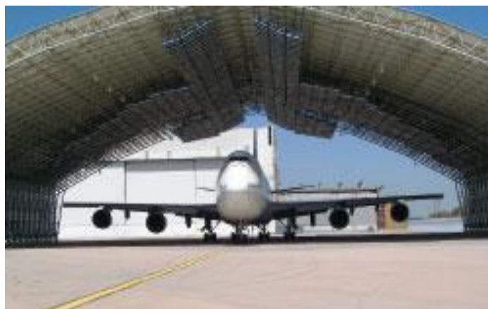
Slika 19. Hangar za odleđivanje zrakoplovnih površina, [45]
