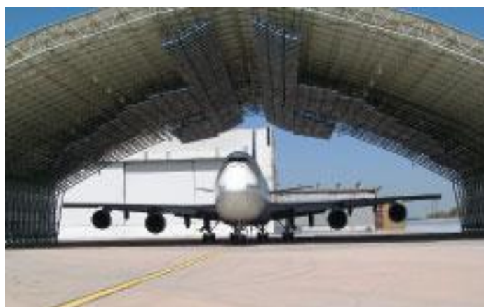
Slika 19. Hangar za odleđivanje zrakoplovnih površina, [45]
