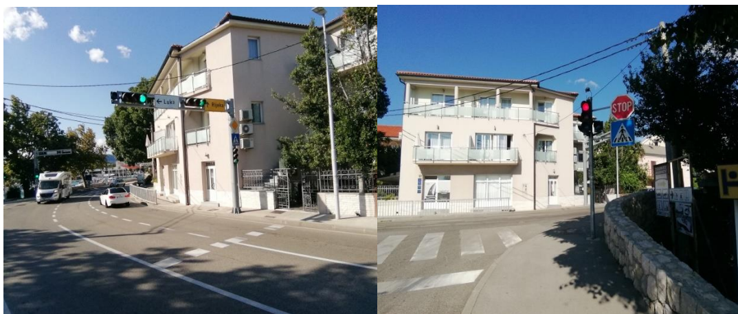
Slika 13. OM Novi Vinodolski – poslije sanacije
