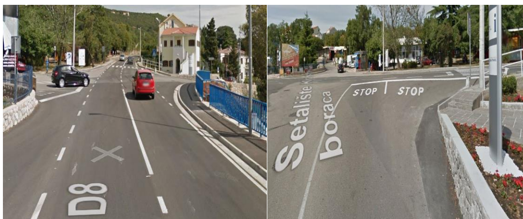
Slika 21. OM Šodići – prije sanacije
