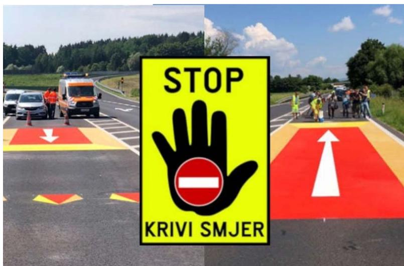
Slika 7. 3D signalizacija za pogrešan smjer na autocestama
