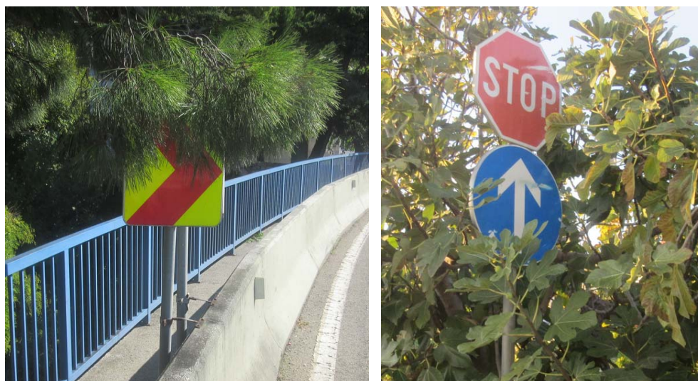
Slika 4. Zaklonjeni prometni znakovi zbog neadekvatnog održavanja okoline ceste
