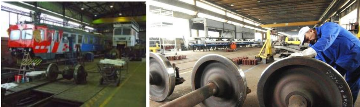
Slika 4.16: Radionica za održavanje željezničkih vozila
