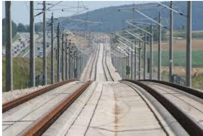
Slika 4.7. Kolosijek bez zastora
