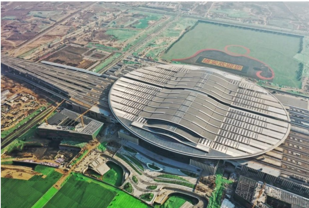
Slika 10. Xiong'an željeznički kolodvor u Peking, [29]
