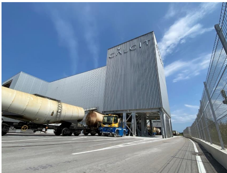
Slika 13. Silos suhih proizvoda
