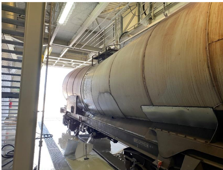
Slika 19. Isticanje nečistoća u podne kanale
