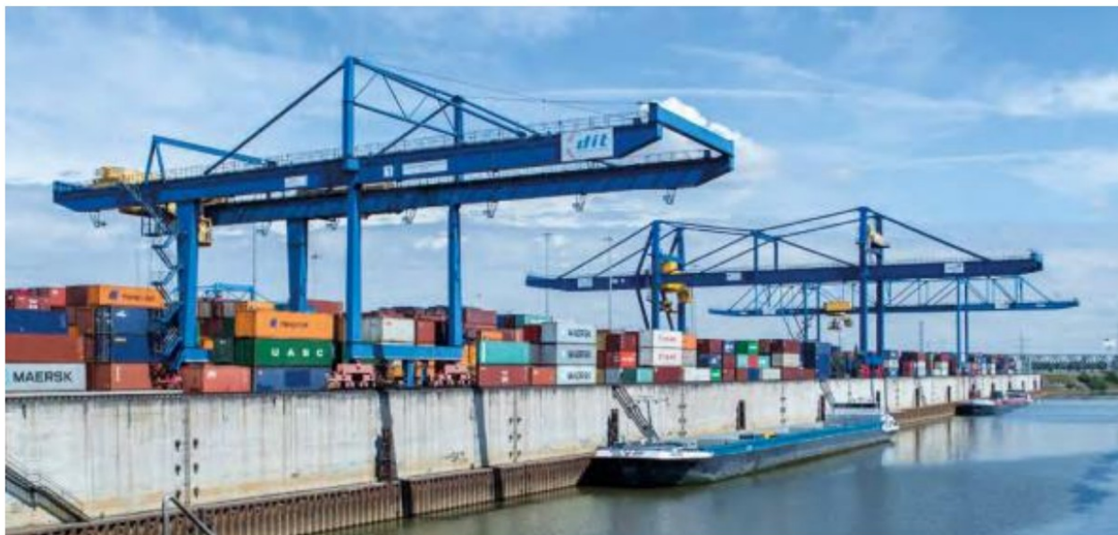
Slika 14. Kontejnerski pretovarni most u luci Duisburg
