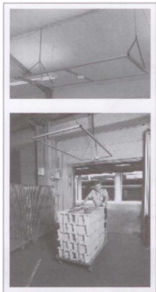
**Slika 11. Niskofrekventna antena**
