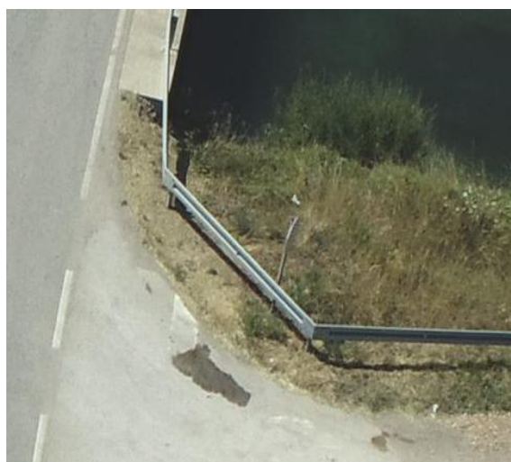
Slika 53 Zaštitna (odbojna) ograda uz cestu (uvećano)
