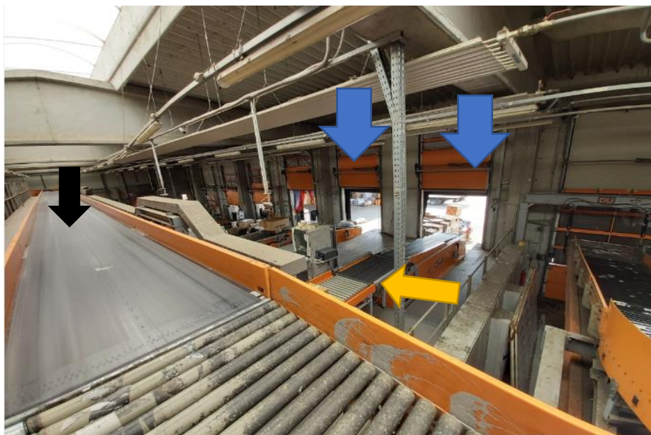
Slika 18. Prikaz iskrcajnih rampi
