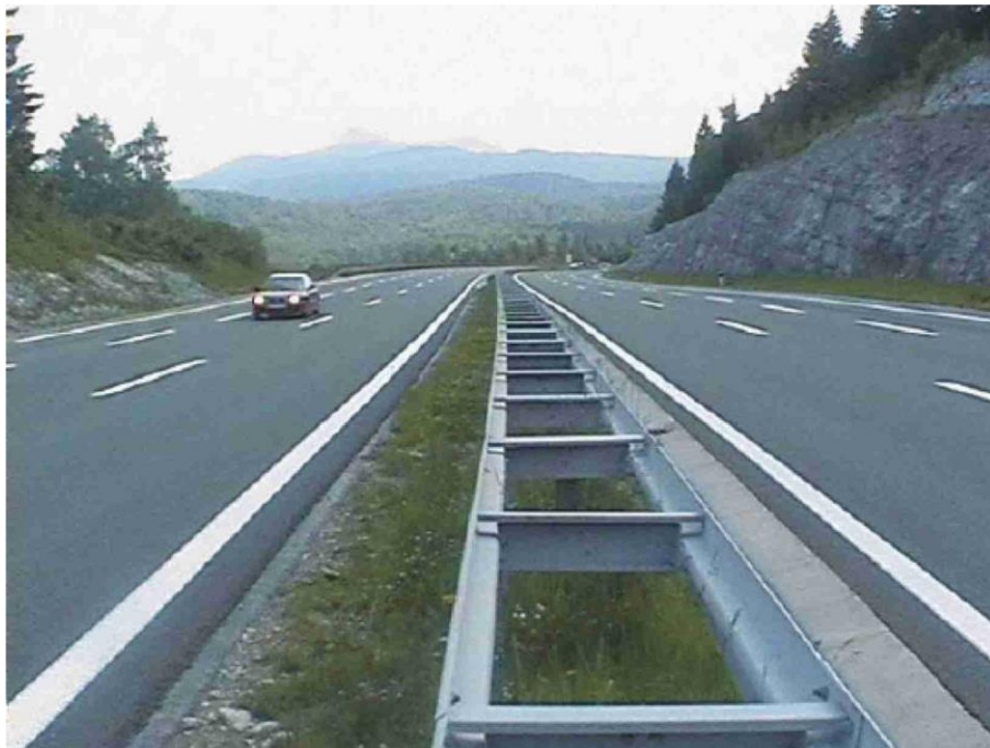
Slika 5. Razdjelni pojas između dva smjera autoceste, [3].
