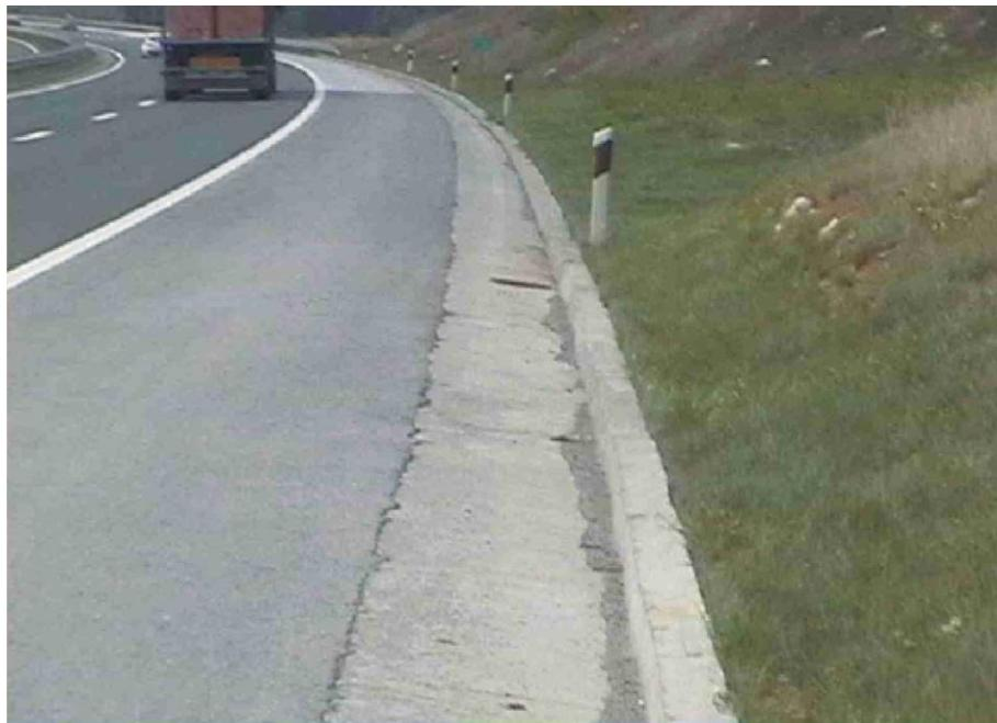
Slika 6. Rigol na autocesti, [3].
