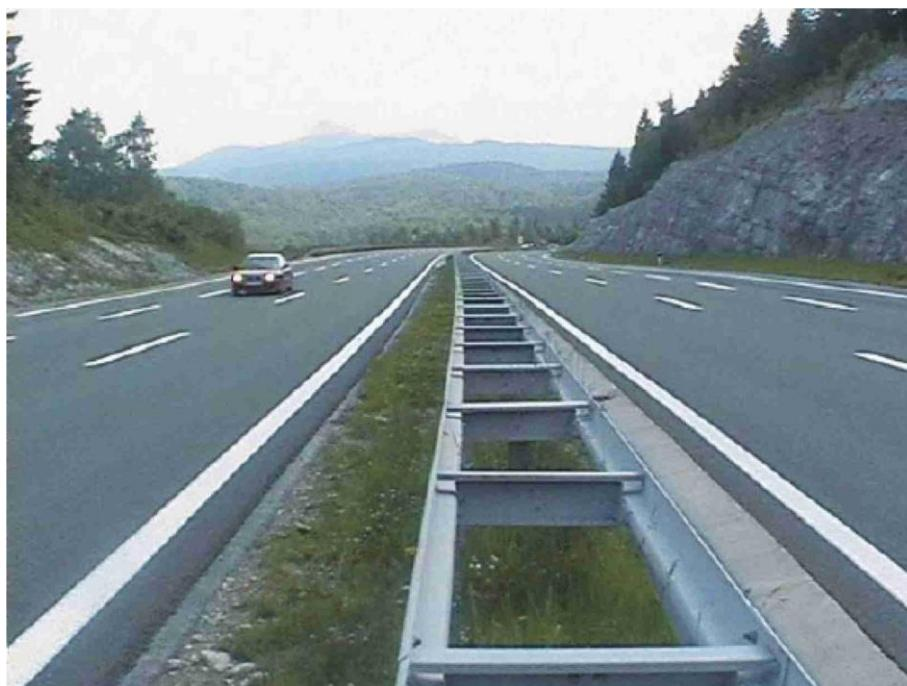
Slika 5. Razdjelni pojас između dva smjera autoceste, [3].
