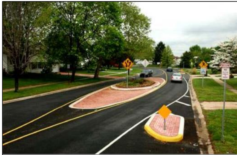
Slika 6 Razdvajanje smjerova vožnje prometnim otokom. Izvor [5].
