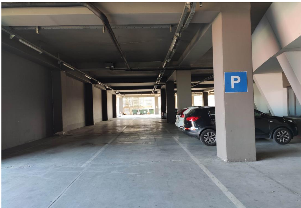
Slika 13. Natkrivena parkirališna površina u sklopu Arene Zagreb
