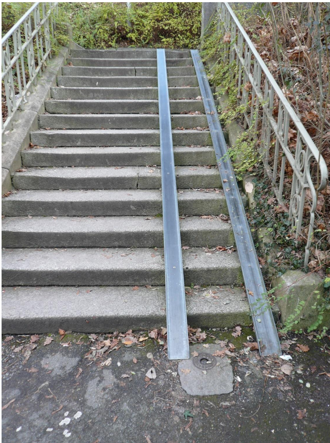
Slika 25. Pomoćna rampa za vođenje bicikla [15]
