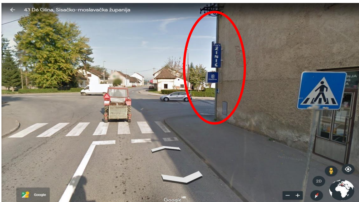
Slika 15. Prikaz infrastrukture koja smanjuje preglednost
