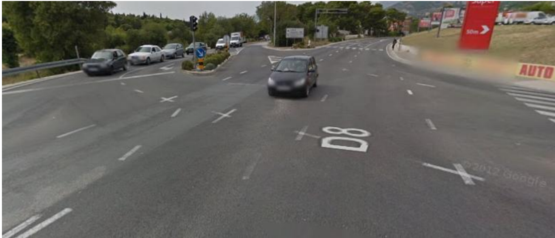
Slika 33. Raskrižje upravljano prometnom svjetlosnom signalizacijom
