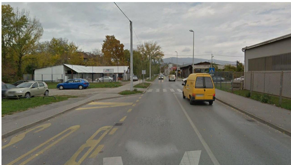
Slika 11. Fotodokumentacija postojećeg stanja - južni privoz (Ulica Dragutina Golika)
