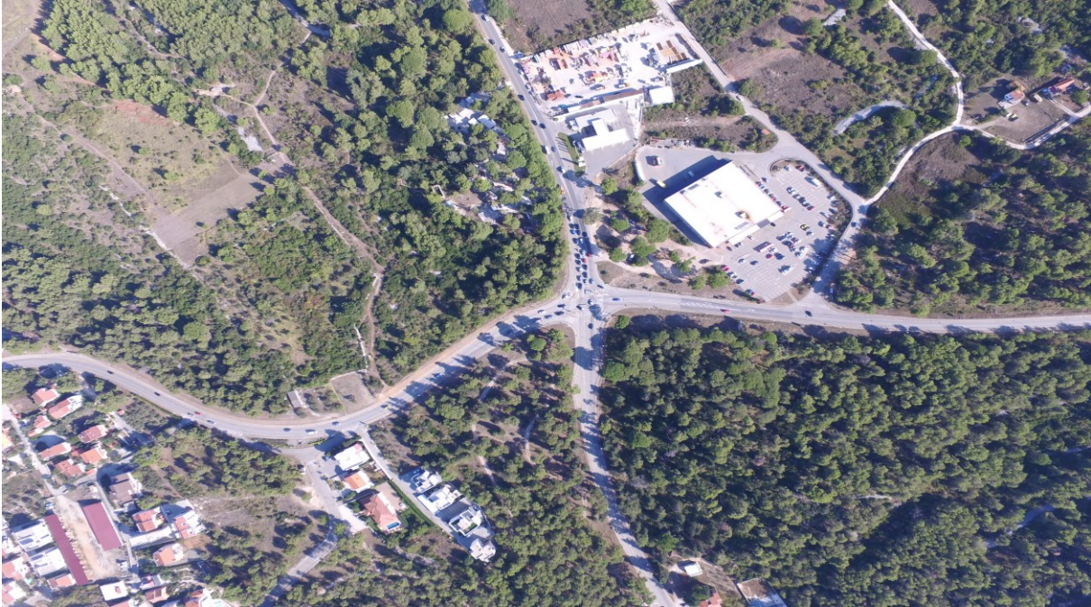
Slika 3.1. Postojeće stanje iz zraka
