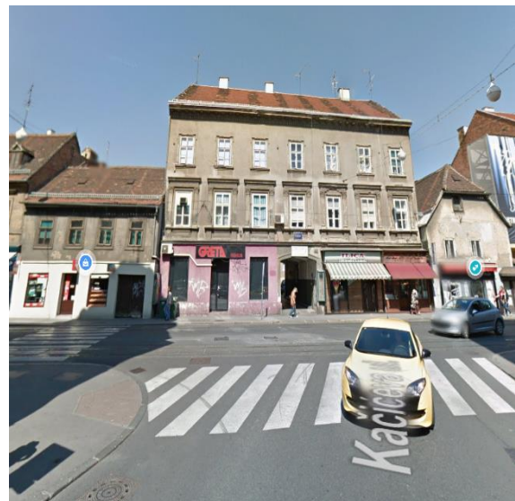
Slika 52. Lokacija 9, Ilica-Kačićeva ulica
