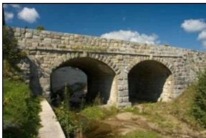
Slika 35. Kameni svođeni most s dva otvora na Luzijanskoj cesti kod Homera blizu Lokvi preko potoka Križ [30]
