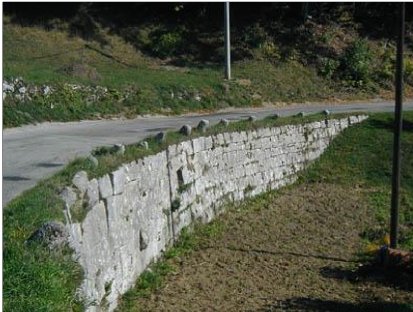
Slika 12. Dio Karolinske ceste sa sačuvanim podzidom[7]
