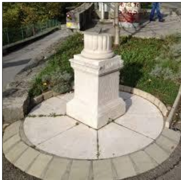
Slika 37. Obnovljena sunčana ura na Lujzijani u Orehovici[32]
