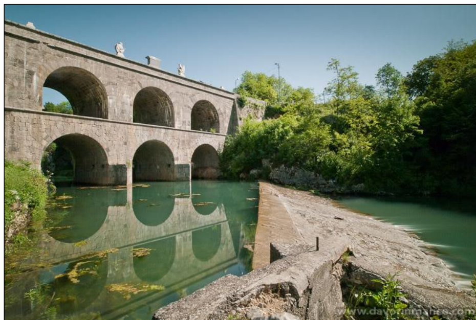
Slika 22. Most u Tounju nakon rekonstrukcije[18]
