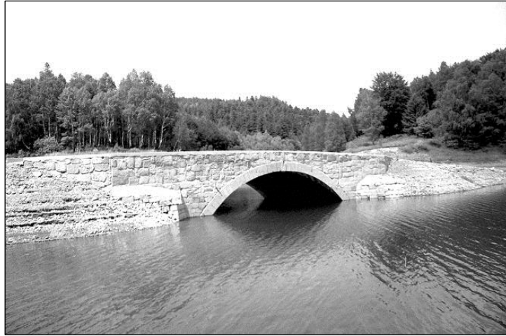
Slika 36. Pogled na obnovljeni Carev most u vrijeme nižeg vodostaja Lokvarskog jezera[11]
