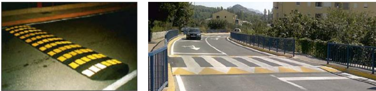
Slika 30. Primjer umjetne izbočine i uzdignute plohe kao mjera za smirenje prometa
