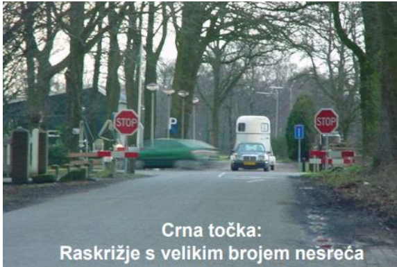
Slika 35. Sanacija crne točke pomoću adekvatne prometne signalizacije
