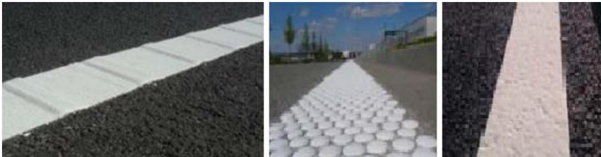
Slika 19. Profilirana, strukturirana i neprofilirana oznaka na kolniku
