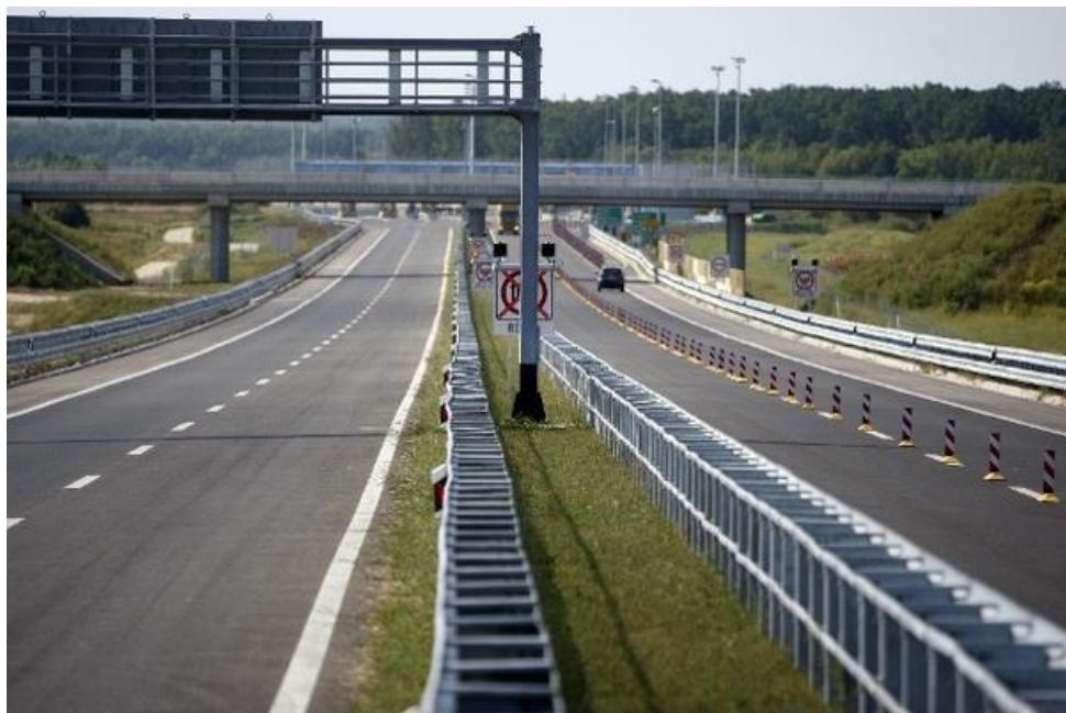
**Slika 8.** Trasiranje ceste sa srednjim trakom za fizičko odvajanje suprotnih smjerova vožnje
