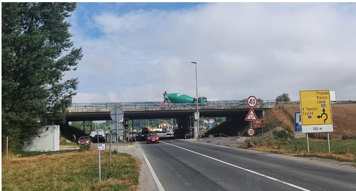
Slika 5. Radovi sanacije nadvožnjaka Gubaševo
