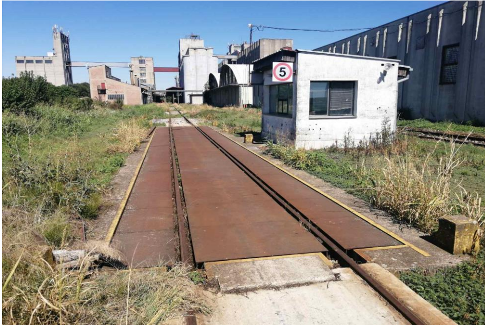
Slika 27 Kolosiječna vaga industrijskog kolosijeka u Vrapčani (Izvor: Autor)
