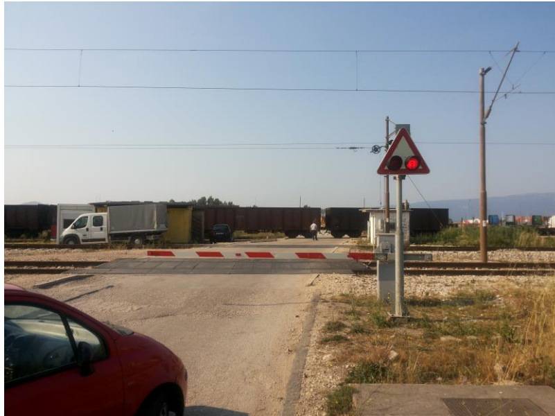
Slika 15. ŽCP Ploče sa spuštenim polubranicima
