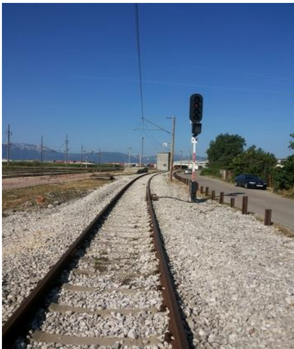
Slika 6. Ulazni signali „AP“ u putnički kolodvor
